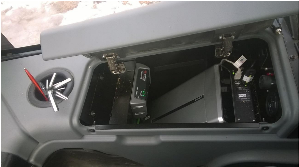
KUVA 2. Esimerkki Sierran modeemin asennuspaikasta metsäkoneessa
