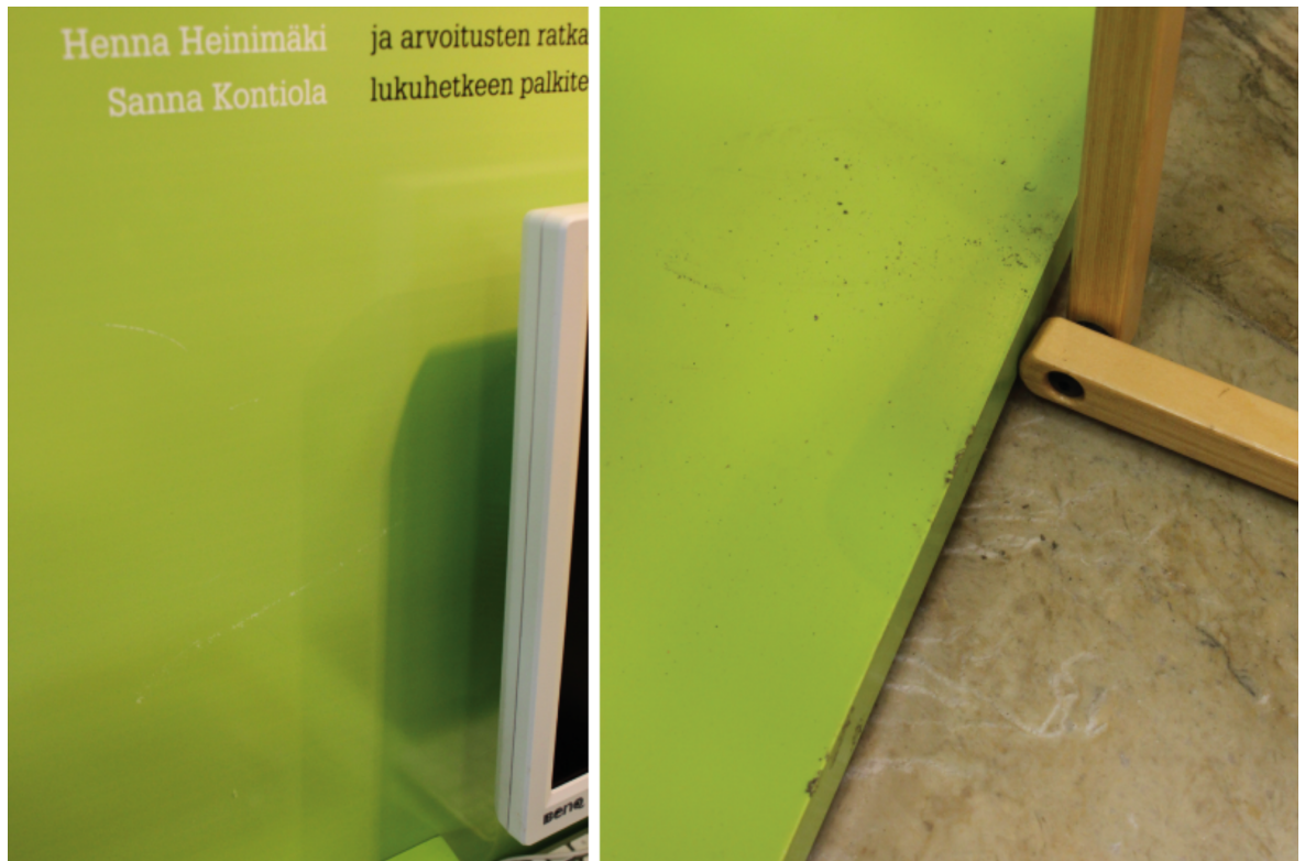
Kuvio 31. Havainnekuvio näyttelyrakenteiden vaurioista; vasemmalla moduulin teippauksen naarmuja, oikealla vauriot moduulin jalka-/tukitasossa.
