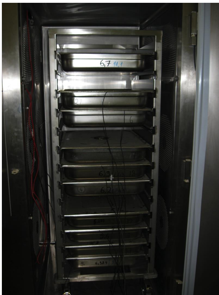
Kuva 14. Pikajäähdyttimen sisätila juuri ennen ensimmäisen testin aloittamista. Edessä näkyvät mustat johdot kulkeutuvat sisällä olevista antureista GL-800-dataloggeriin.
