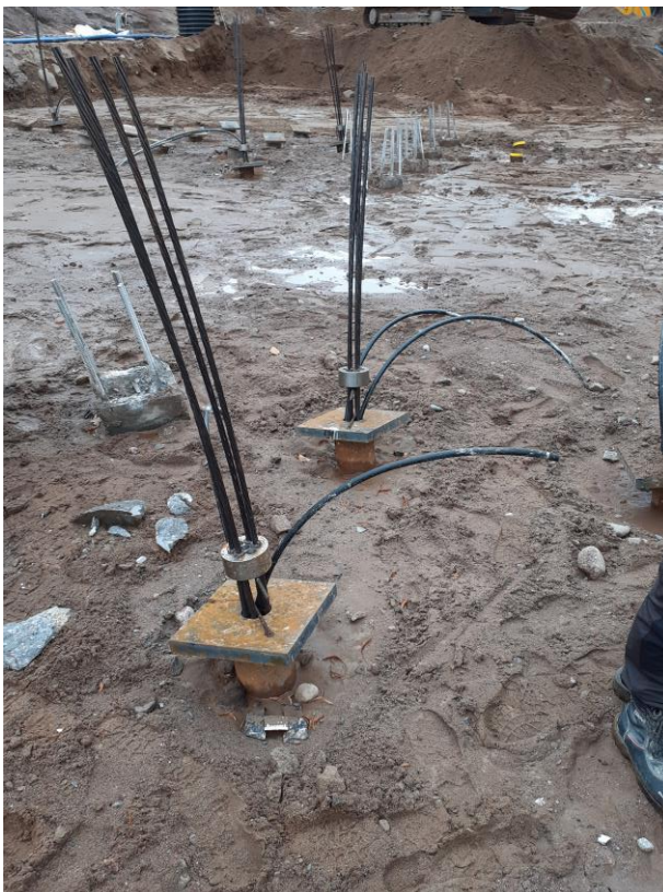
Kuva 4 Porapaaluun tiputettuja punosankkureita
