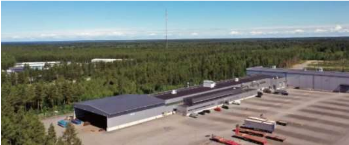
KUVA 1. Raahen toimipaikka, Kiiluntie 2 (FSP For Surface Protection Oy.)
