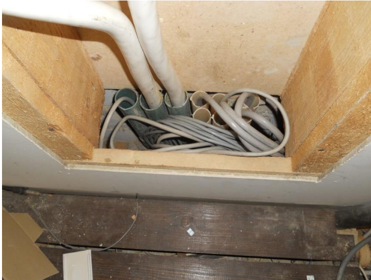
KUVA 40. Pohjakerroksesta tulevia muoviputki
