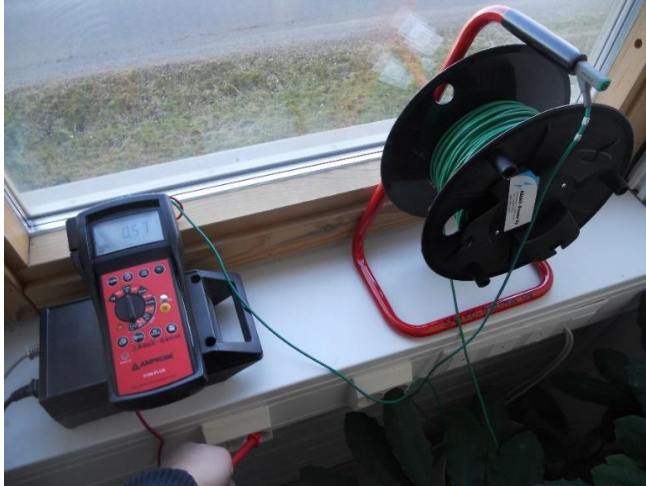
KUVA 70. Jännitteettömiltä pistorasiaryhmiltä mitattiin suojajohtimen jatkuvuus
