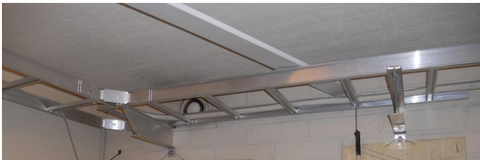
KUVA 1. Alumiininen tikashylly seinäkiinnikkeillä.
