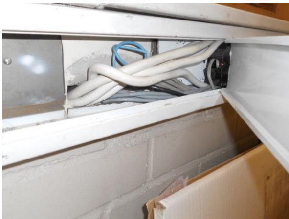
KUVA 33. Johtokanava sisältä
