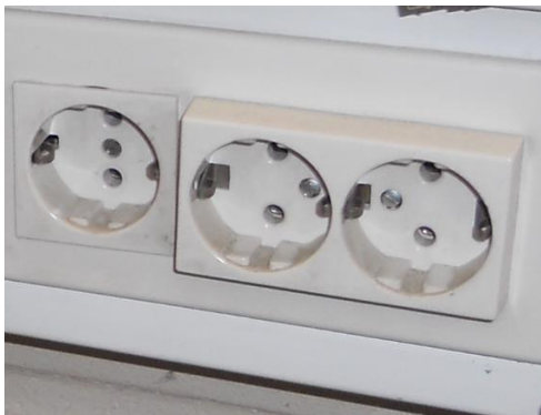
KUVA 5. Maadoitettuja pistorasioita.
