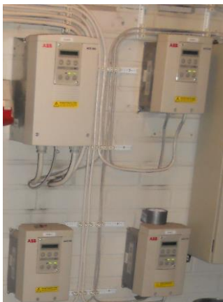
KUVA 66. Ilmanvaihtolaitteiston taajuusmuuttajat
