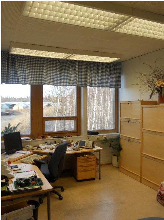
KUVA 8. Toimisto on valaistu neljällä loisteputkivalaisimella.
