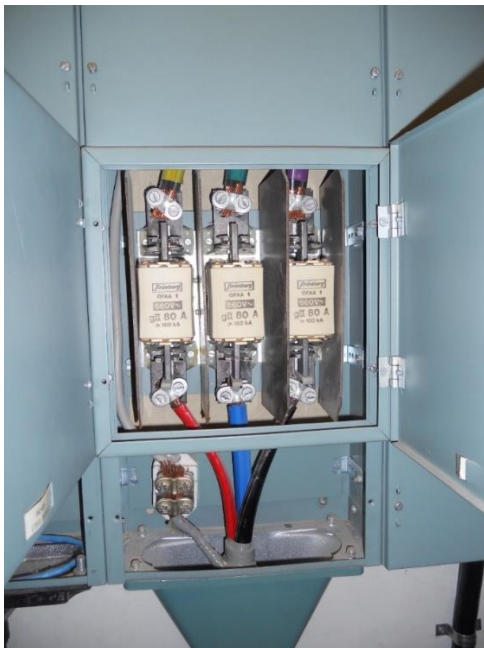
KUVA 46. Kavavarokealustat ovat hyväkuntoisia
