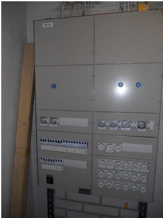
KUVA 53. IV-ryhmäkeskus on uusittu 2000-luvulla
