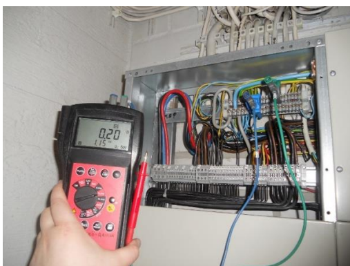
KUVA 57. Oikosulkuvirran mittaus keskukselta
