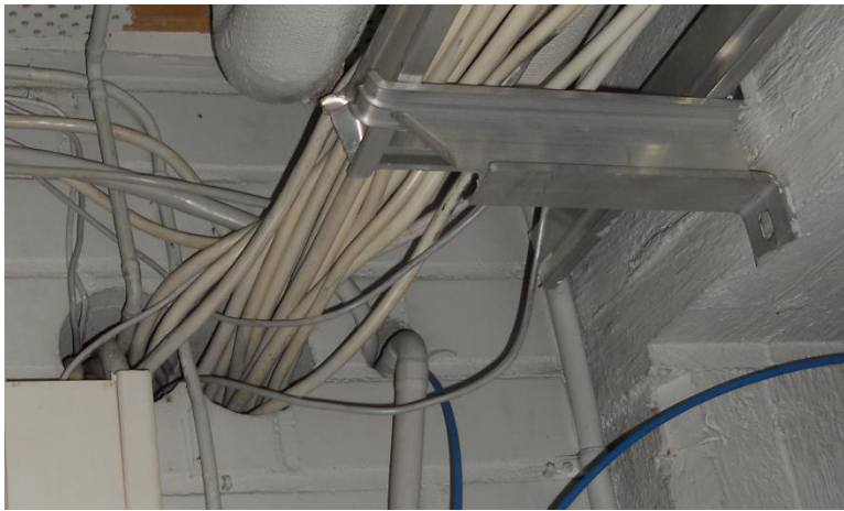
KUVA 38. Läpivienneissä on tilaa uusille asennuksille
