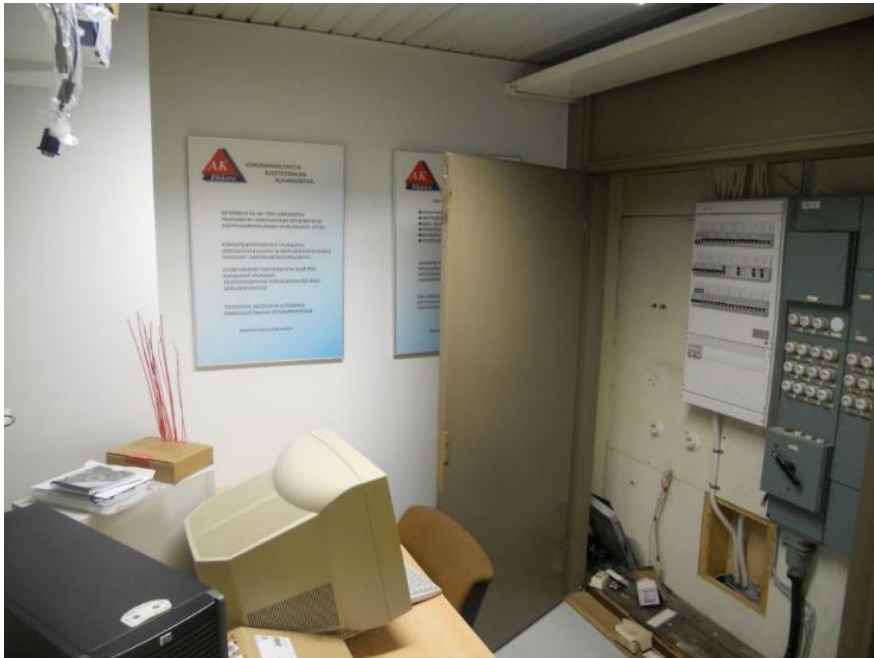
KUVA 44. 1. kerroksessa keskuskomeron ovet on jätetty lukitsematta
