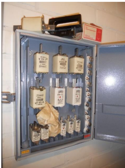
KUVA 42. Vaihtosulakekaappi ja kahvasulakkeiden vaihtokahva
