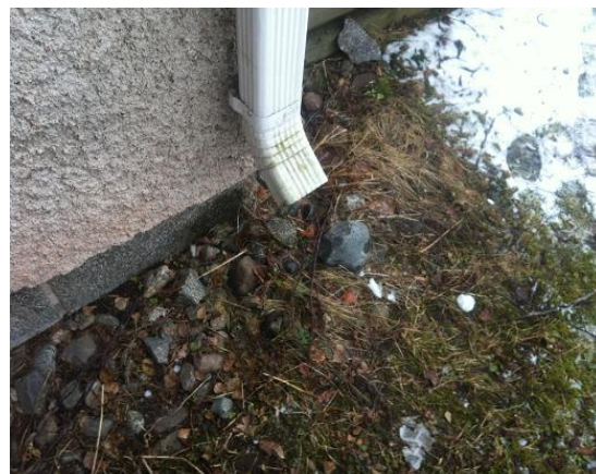
Maanpinnan kallistukset ovat puutteelliset. Puuttuva sadevesikaivo.
