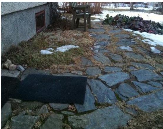
Maanpinnan kallistukset ovat puutteelliset. Puuttuva sadevesikaivo.
