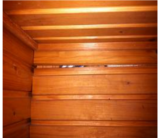
Saunan paneelien pontti on auki.
