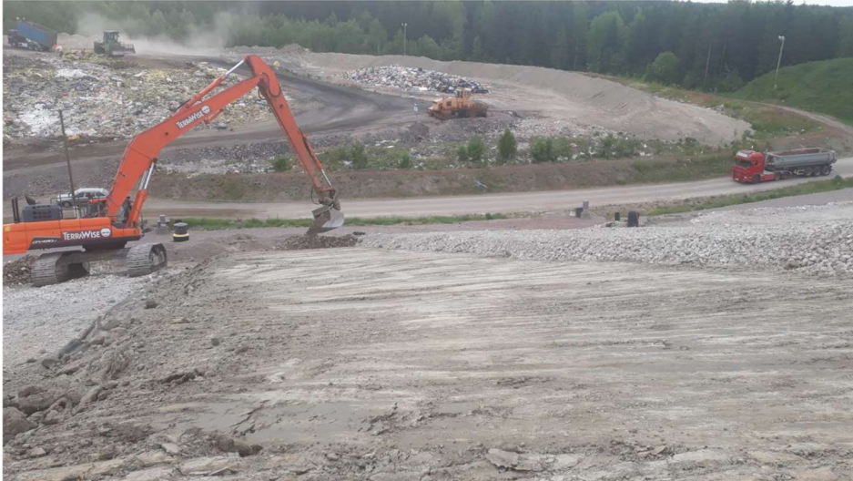
Kuva 3. Kaivinkone rakentaa tiivistyskerroksen viimeistä kerrosta.
