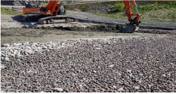
Kuva 11. Kaivinkone rakentaa luiskaan tiivistyskerrosta.
