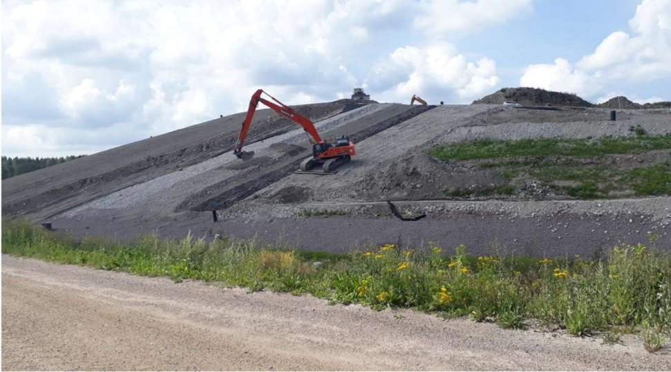
Kuva 2. Tiivistyskerroksen koekentän rakentaminen.
