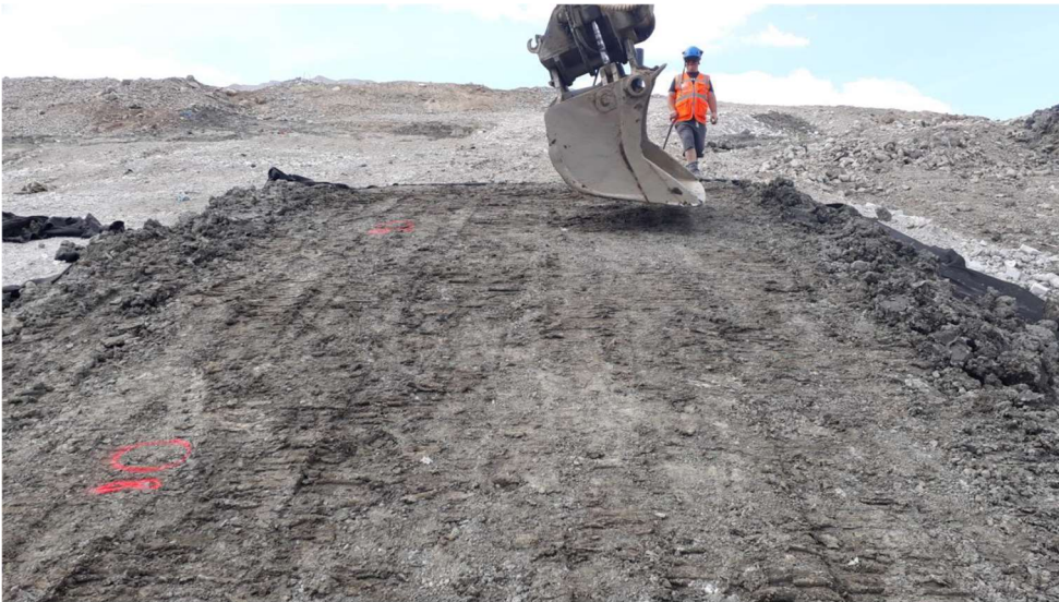
Kuva 2. Tiivistyskerroksen koekentän rakentaminen.
