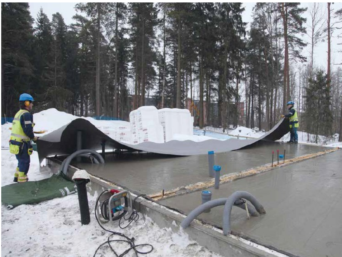
Kuva 2. Lämpöä eristävän peitteen asennus (Betonin lämmittäminen talvivaluissa 2011, 12)
