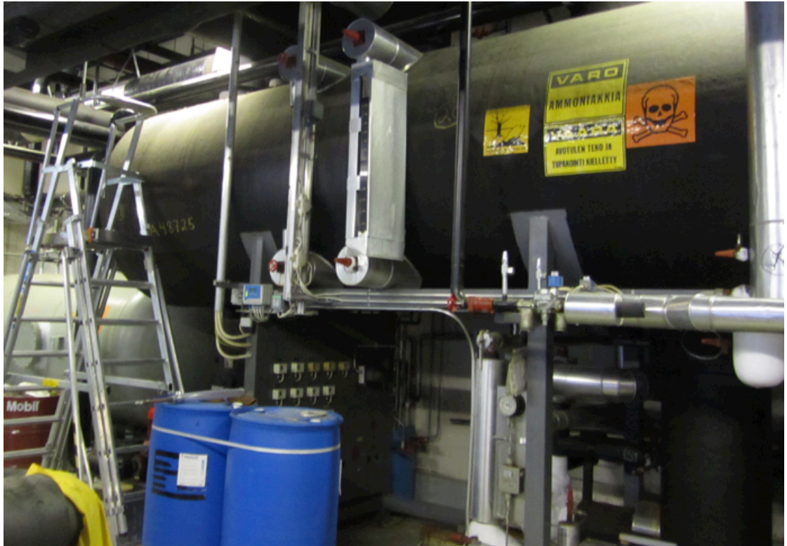
Kuvio 11. Pumppusäiliön tilavuus 12 m 3 , säiliö varustettu pinnankorkeusindikaattorilla.
