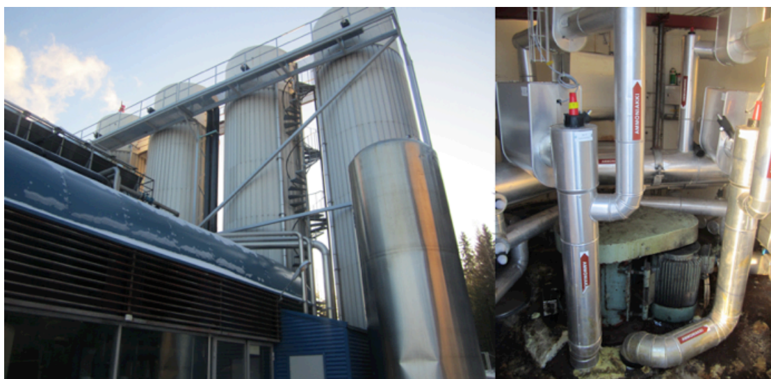
Kuvio 10. Jäävesisiilot, sekoittaja sekä lauhduttajien vesisäiliö
