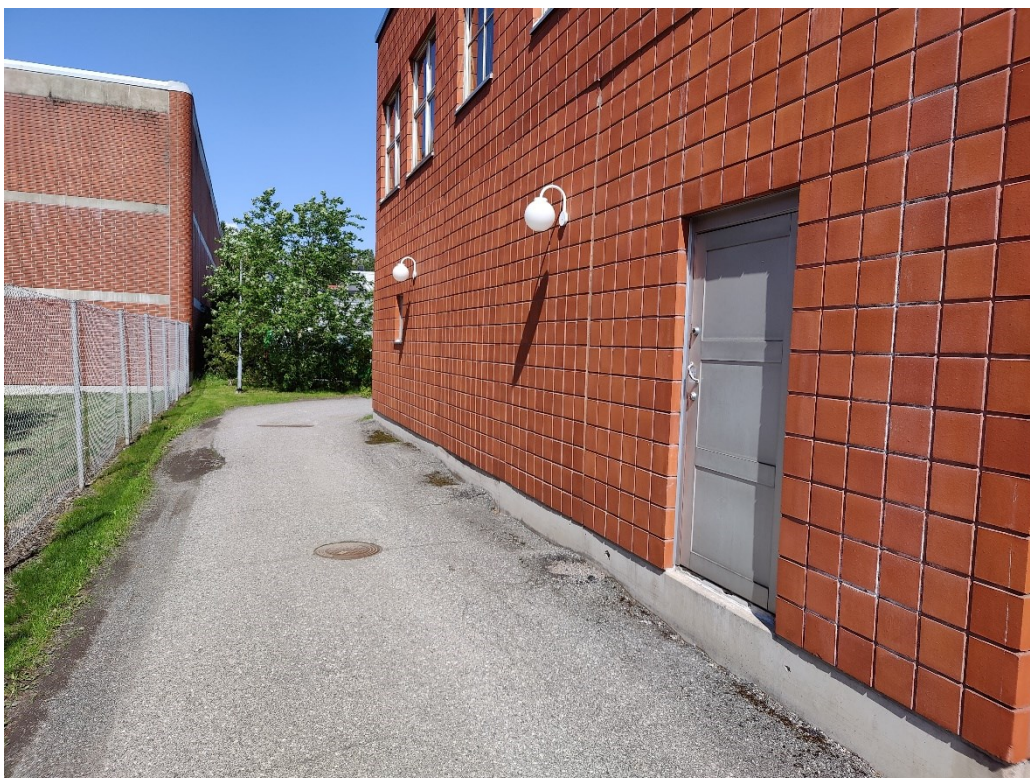
Kuva 1. Varaston ulko-ovi kuvattuna ulkopuolelta ja pelastustie.
