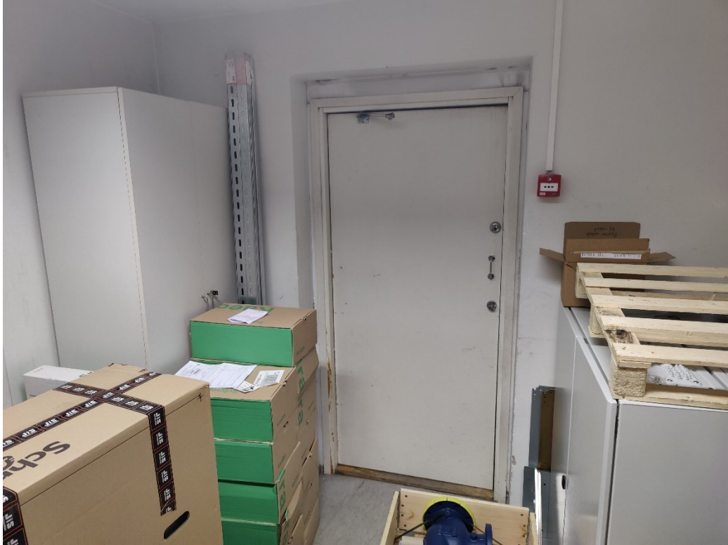
Kuva 2. Varaston ulko-ovi kuvattuna sisäpuolelta
