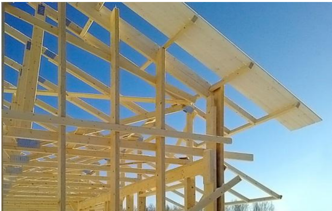
Figur 4. Exempel på platsbyggd trästomme för mindre träbyggnader (Trendikoti 29.10.2009).
