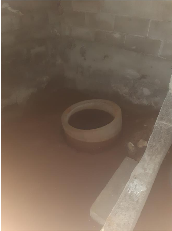
Kuva 6. Veden poistamiseen tehty kaivanto
