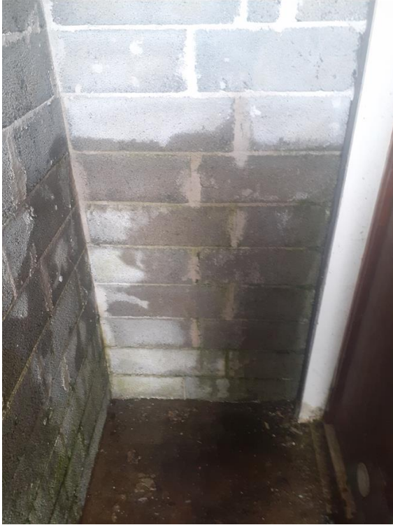
Kuva 5. Kellarin maanvastainen seinä
