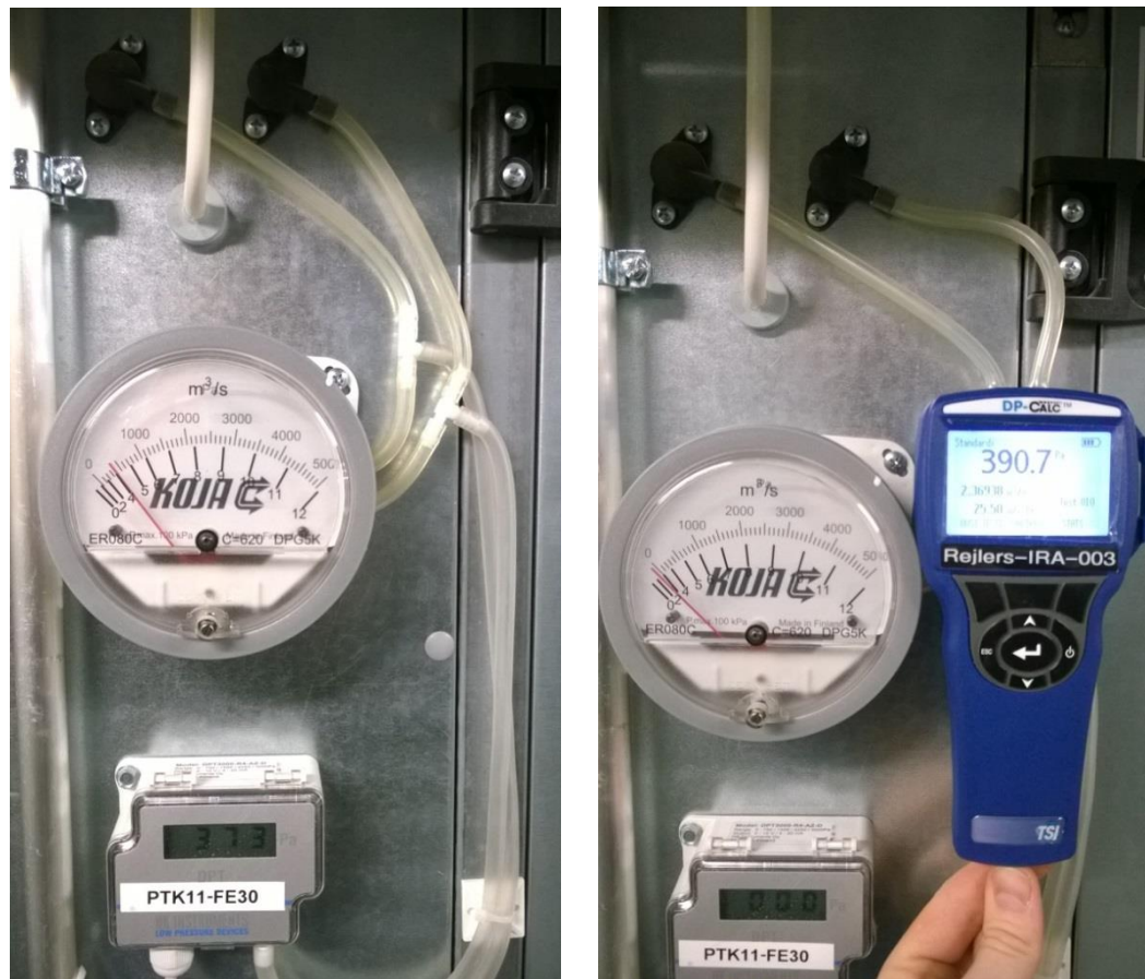
KUVA 7. Paine-eromittarin kytkentätapa
