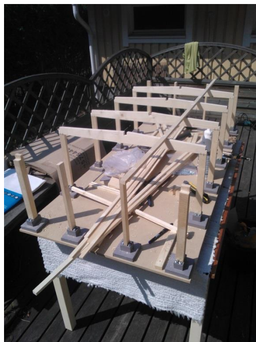
Kuva 6. Harjapalkkien asennus
