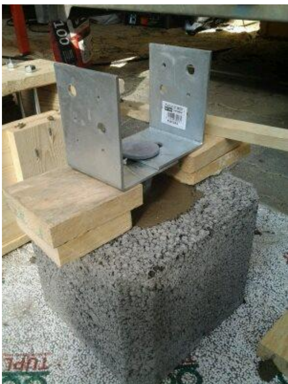
Kuva 9. Nivelellinen pilarikenkä valettuna harkkoon
