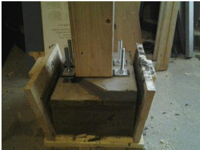
Kuva 10. Momenttijäykkä pilarin kiinnitys
