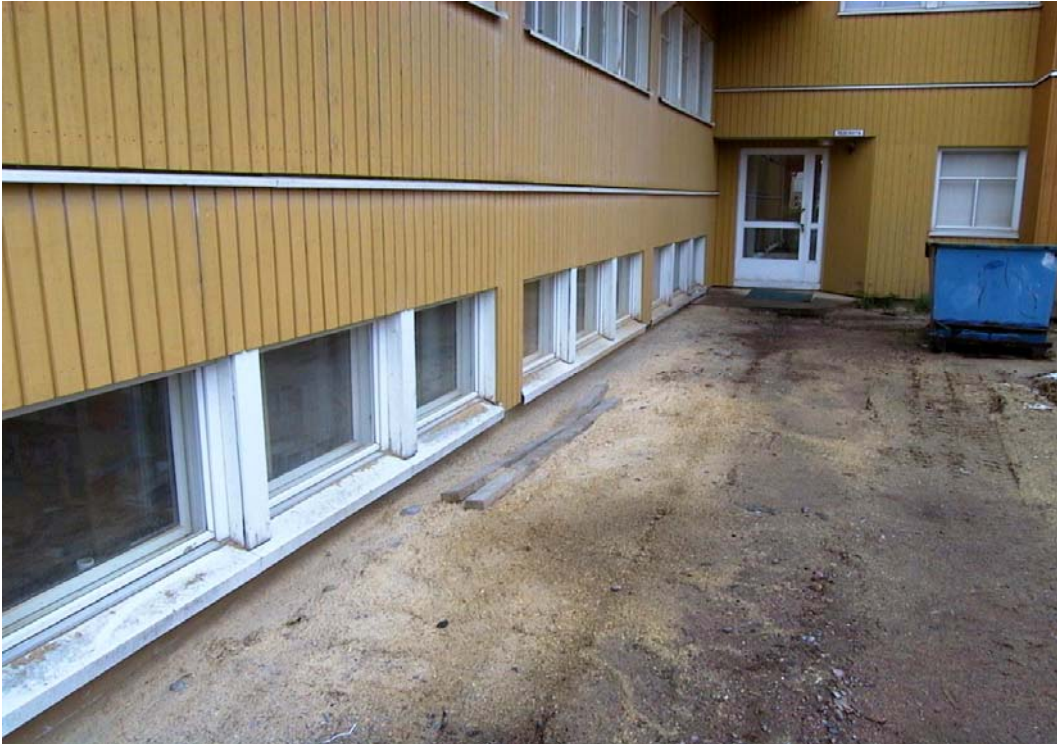
11. Sama tilanne on välikön toisellakin seinustalle ja jopa huonompi, koska ikkunat ovat alempana, on pölyn kertyminen suurempaa.
