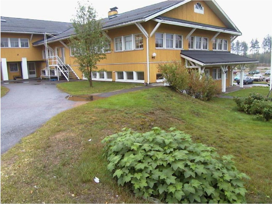
13. Nurmialueet ovat suurelta osin vanhentuneet ja sammaloituneet. Myös multakerros on liian ohut nurmen kasvamiseen.
