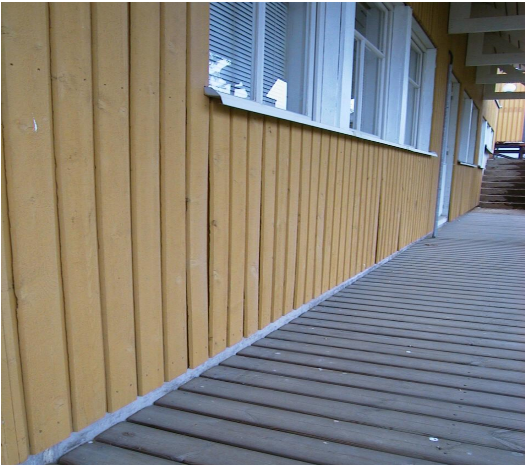
12. Ulkovuorilaudoitus kaipaisi maalausta ja kiinnityksen tarkistamista.
