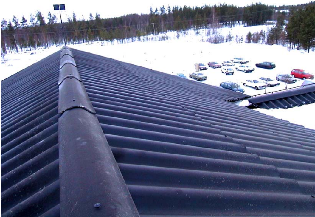
1. Kiinnitysnaulat ovat useasta kohti koholla katteesta.
