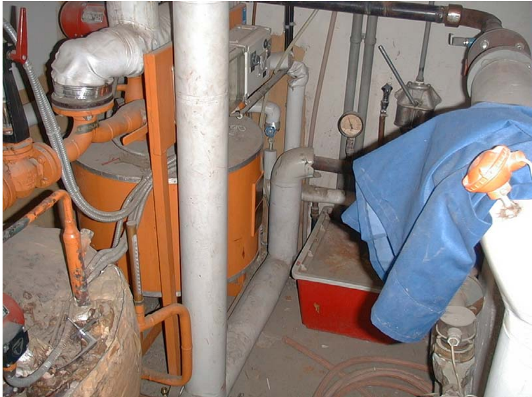
15. Lämmityksen lämmönvaihdin on päällisin puolin paremmassa kunnossa.
