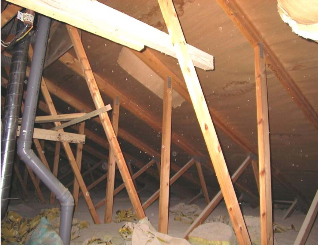
3. Pohjois-siipi on melko hyväkuntoinen ja aluskatteen limitys on riittävä (n.10 cm)
