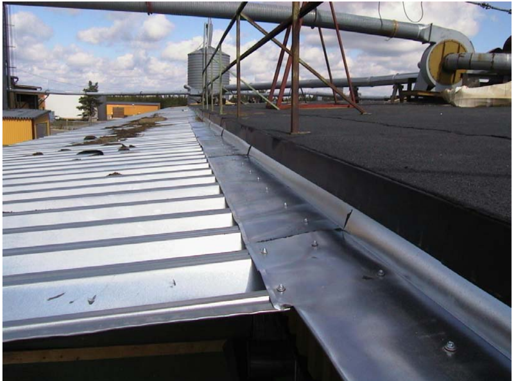
3. Pokattupelti ja tiiviste on asennettu liitokseen.
