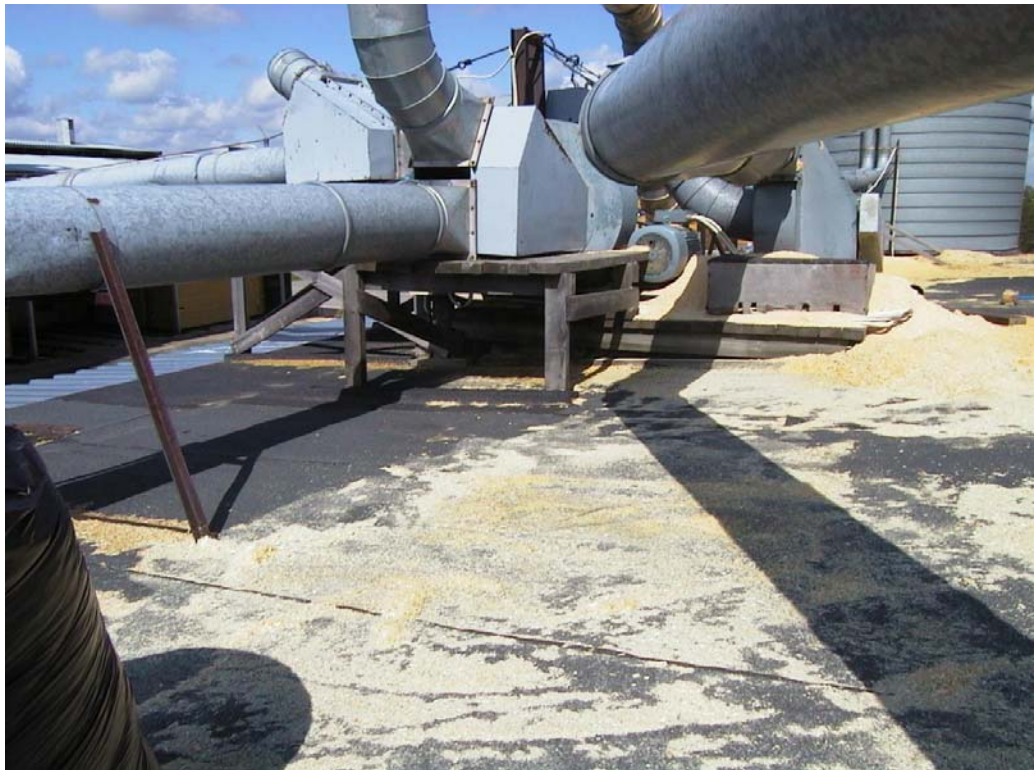
6. Siirtoimuri pohjoispäässä. Runko on tehty suoraan huovanpäälle. Runko on ajan myötä painunut huovasta läpi. Runko pitäisi nostaa kokonaan ilmaan, jotta uudet huovat voisi asentaa pukkien alle.
