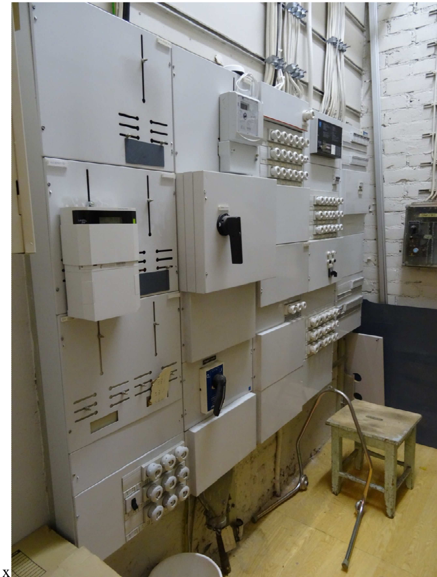
Kuva 11. Sähköpääkeskus.
