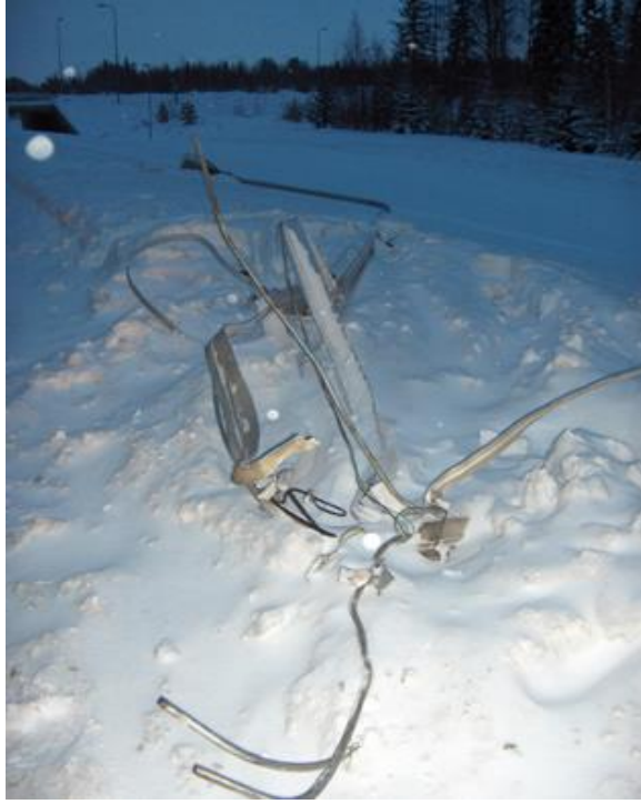
Kuva 9. Myötävä metallipylväs törmäyksen jälkeen.
