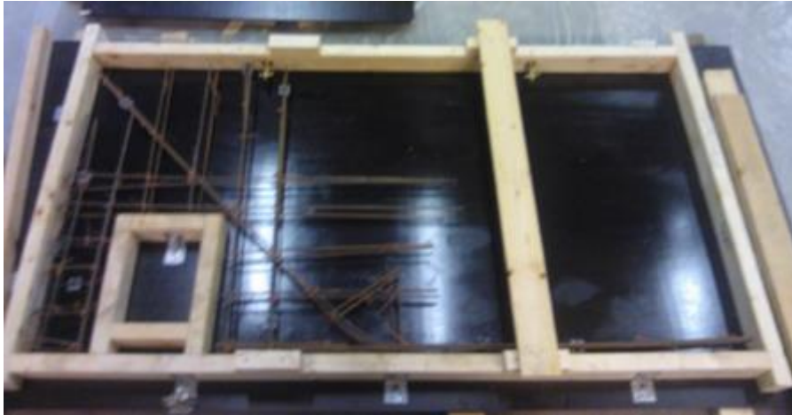
Kuva 4. Koekappaleen 3 muotti ja raudoitus (Kuvasta puuttuu yläpinnan reunateräs).
