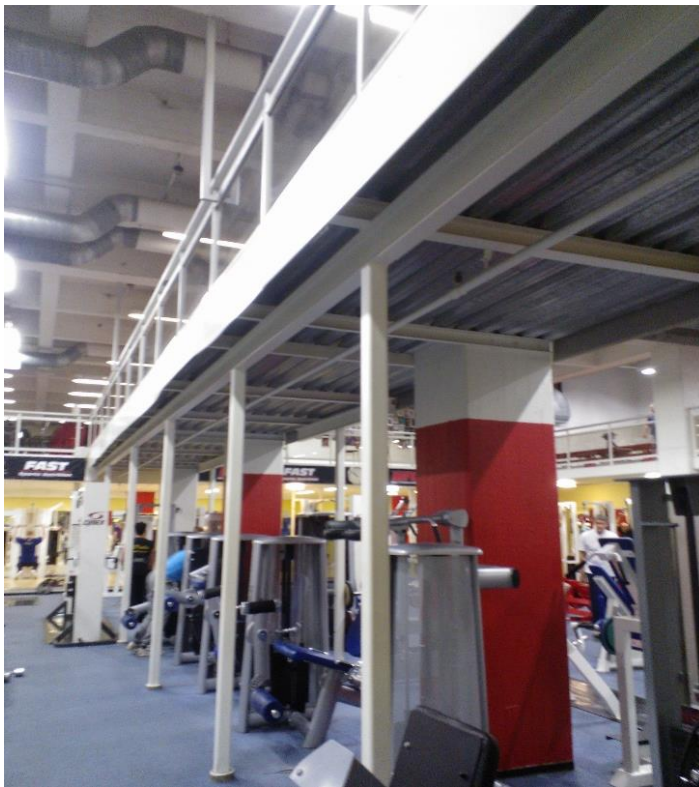
Kuva 1. Nykyinen siltarakenne (Kuva: Joni Koivula 2014)
