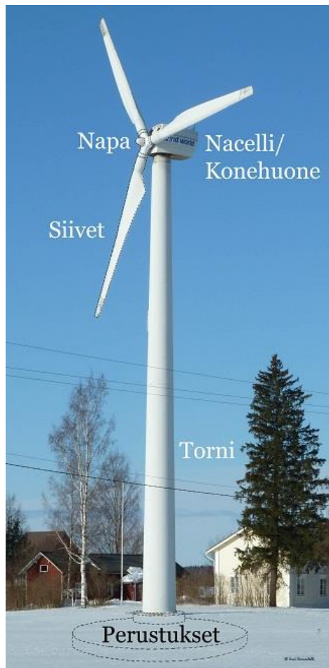
Kuva 5. Tuulivoimalan rakenne (18.)
