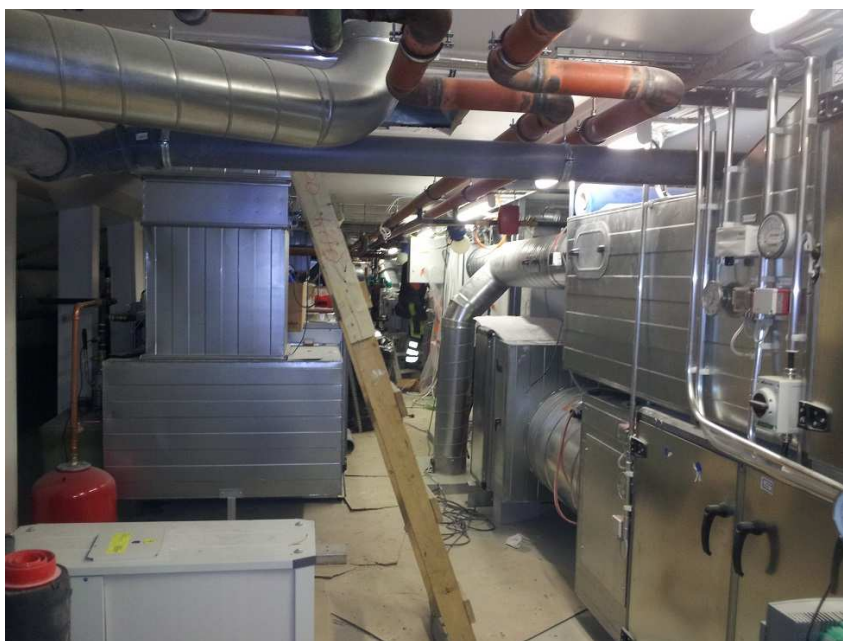
Kuva 6. IV-koneet paikallaan. Kuva: Henri Tavaststjerna.
