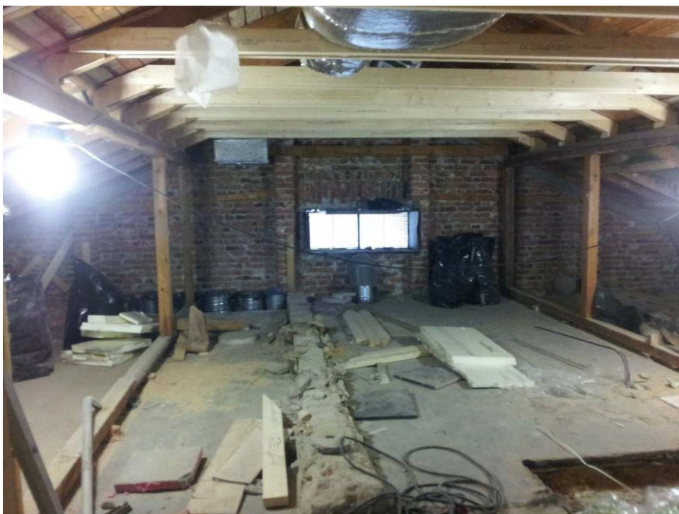
Kuva 3. Ullakkotila purettuna. Kuva: Henri Tavaststjerna
