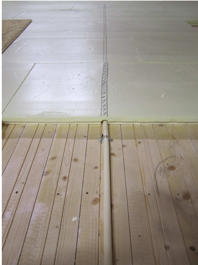
Figur 17. Skyddsörren fälls in i EPS isoleringen. Ovanpå isoleringen syns OSB skivan. (Dennis Hindersson )
