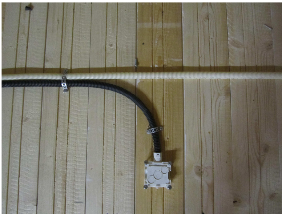
Figur 15. Elkablar med skyddsror dragna ovanpå panelen. (Dennis Hindersson)
