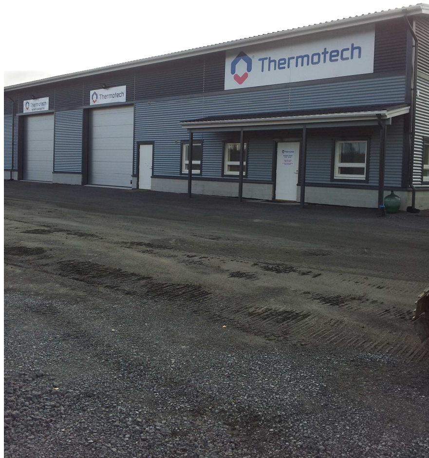
Figur 12. Thermotechs del av byggnaden. Längst till höger ser man kontorsdelen. ©Linda Förström.
