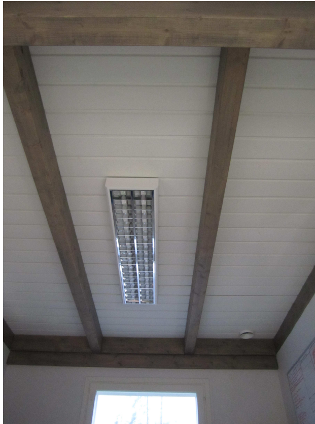
Figur 16. Mellanbjälklagskonstruktionen sett underifrån. (Dennis Hindersson)
