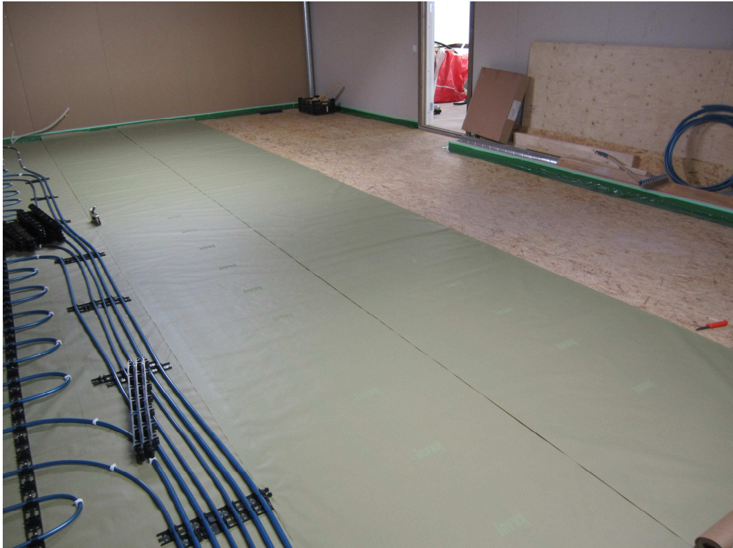
Figur 18. Det diffusionstäta pappret och kantbandet är installerat. Golvvärmens installeras. (Dennis Hindersson).
