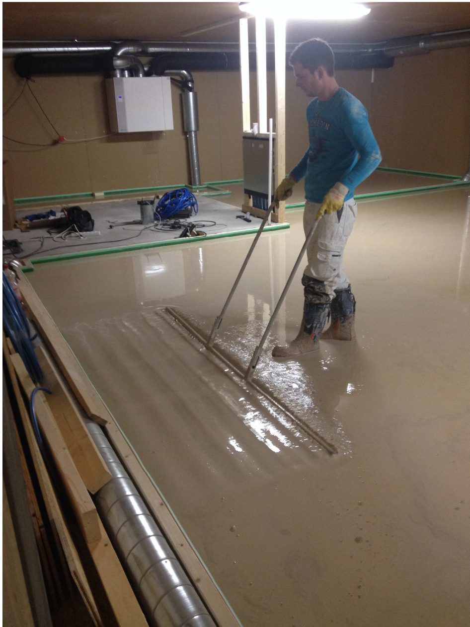
Figur 22. Utjämnandet av ytan pågår. (Dennis Hindersson)
