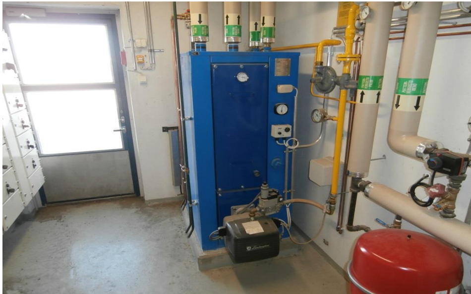
Kuva 16 Toimistotilan maakaasukattila
