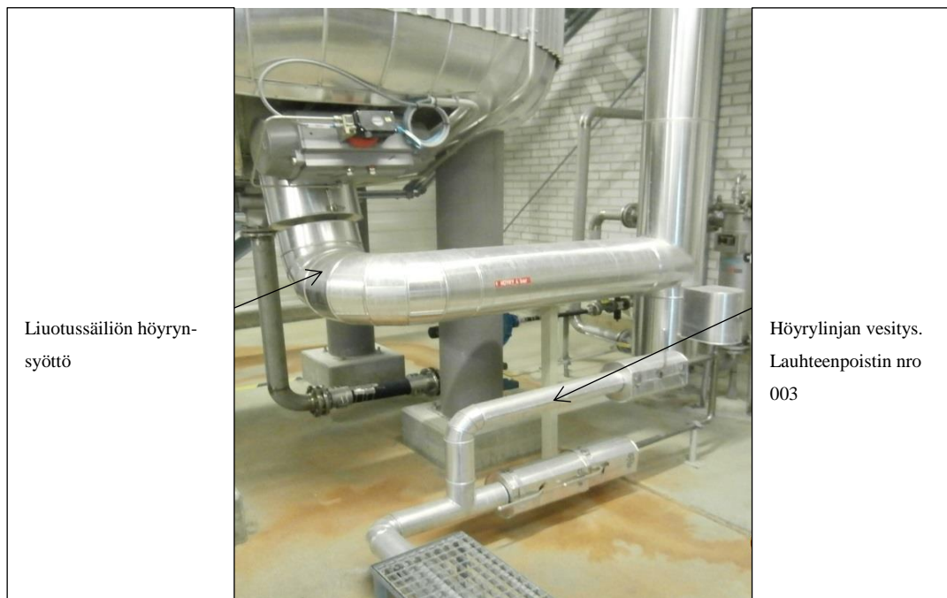
Kuva 8 Liuotussäiliön lämmitys liuotusosastolla
