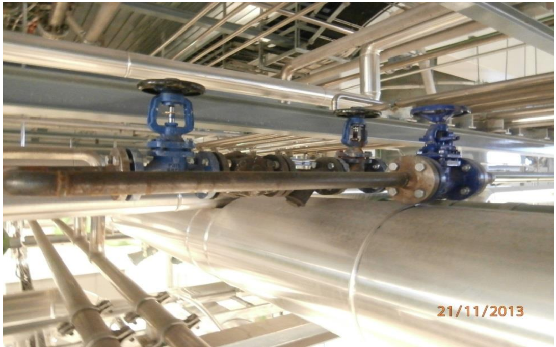
Kuva 27 Tuotantotilan ilmastoinnin ohitettava alapoistin nro 021
