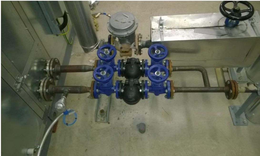
Kuva 26 Tuotantotilan ilmastointi ja uudet poistimet 22 ja 23 Spirax FT14-4,5
