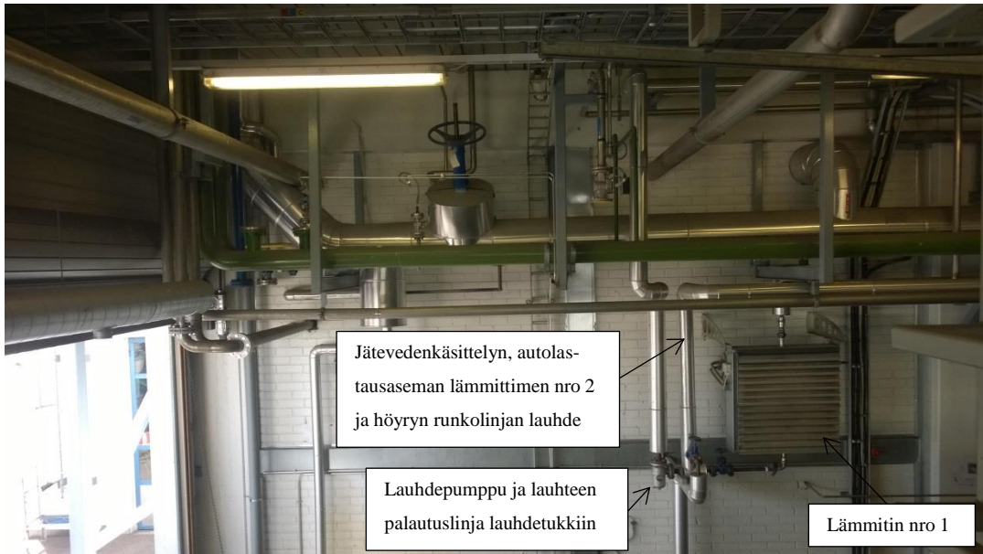
Kuva 13 Lauhteiden keruu ja siirto autolastausasemalla tasolla 0
