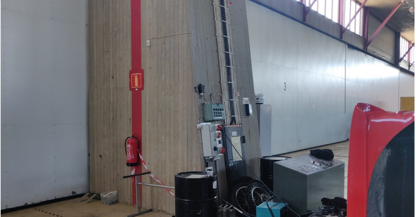
Kuva 3. Tuotantotilassa sijaitseva katon tukirakenne.
