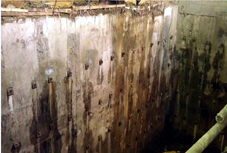
Kuva 4. Kaivantoseinämenetelmän käyttö asuinrakennuksessa [7].
