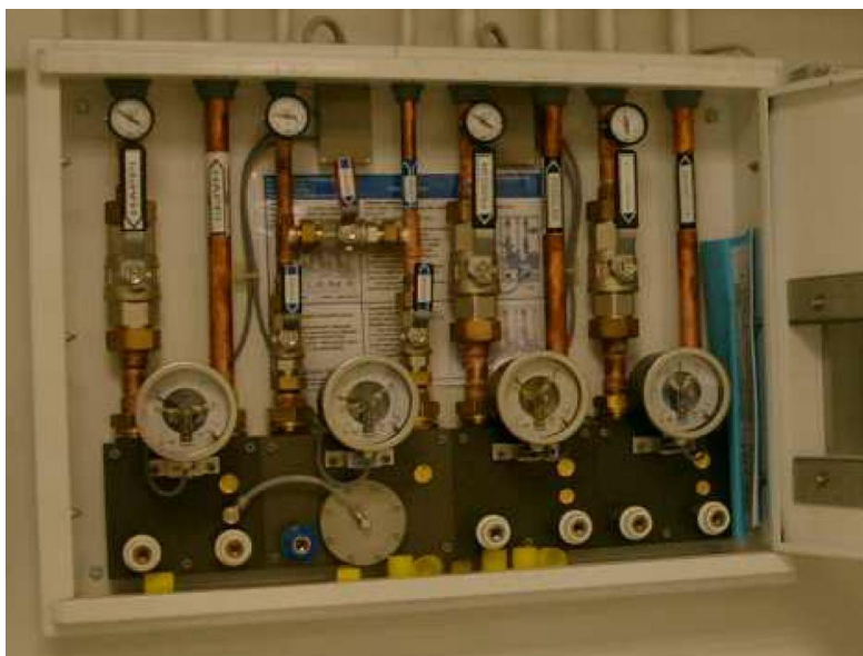
KUVA 7. Painevahti neljälle kaasulle (Sa-Va 2013a)
