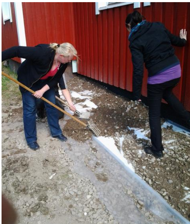
Kuva 8. Jokihelmen routaeristyksen tekoa
