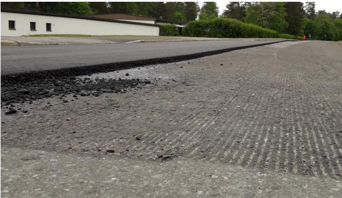
Kuva 12. Ajouradan toinen kaista asfaltoitu, liimatulle pinnalle.
