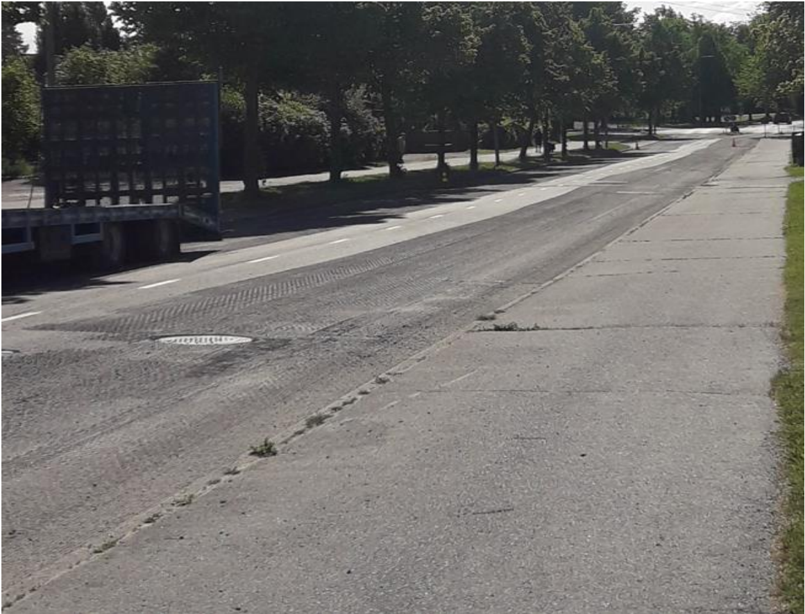
Kuva 12. Ajouradan toinen kaista asfaltoitu, liimatulle pinnalle.
