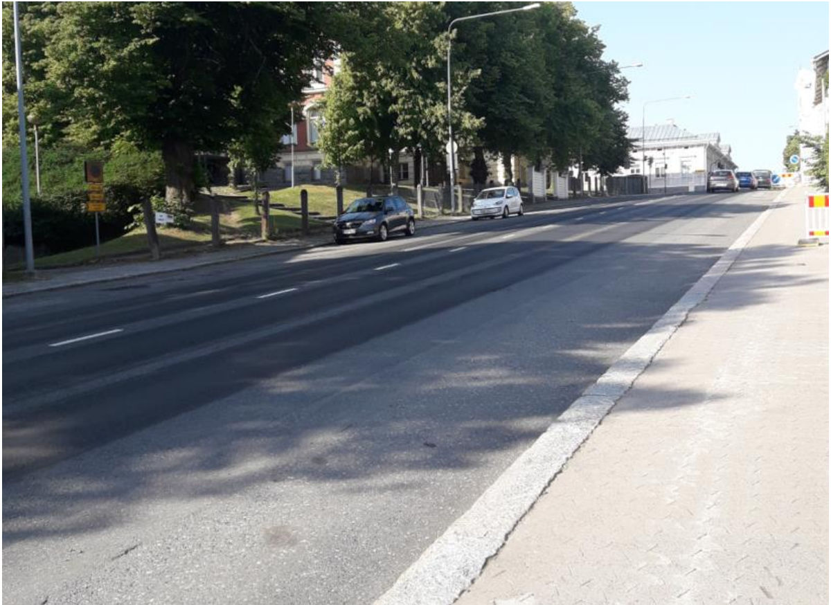
Kuva 20. URAREMIX- menetelmän valmis asfalttipäällyste.
