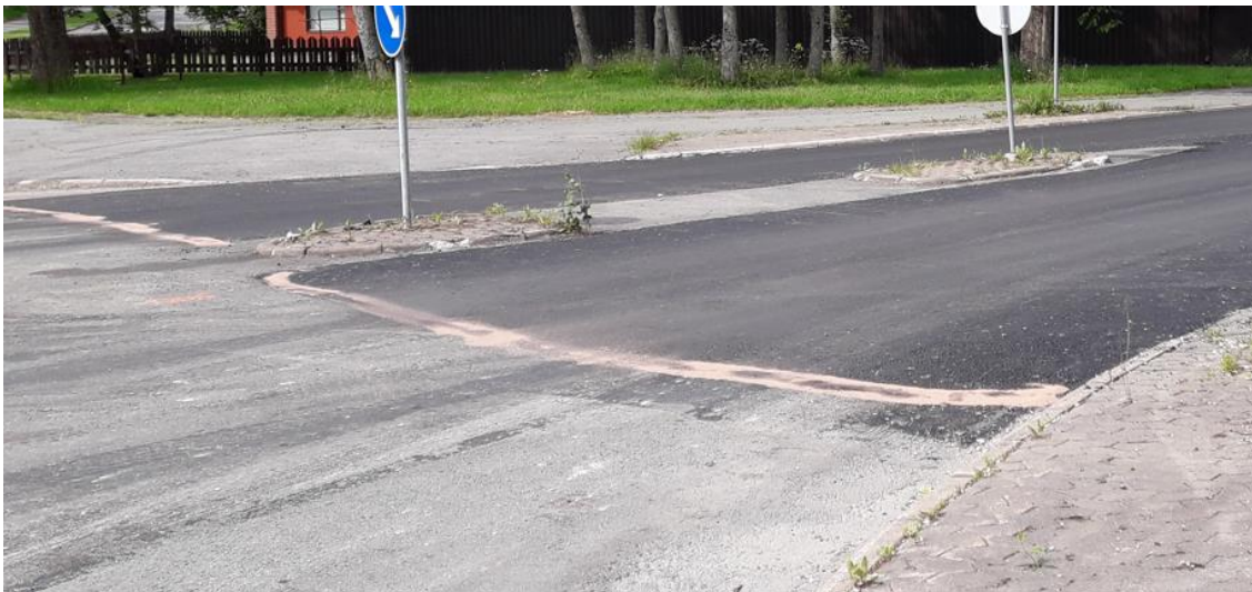
Kuva 13. Uuden ja vanhan asfalttipäällysteen liitoskohta.
