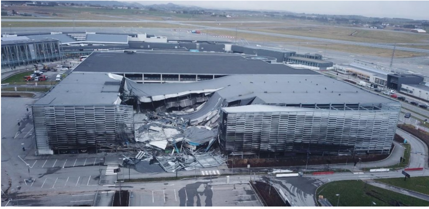
Kuva 24. Stavangerin lentokentän parkkihalli 7 tulipalon jälkeen. (Nordic Unmanned)
