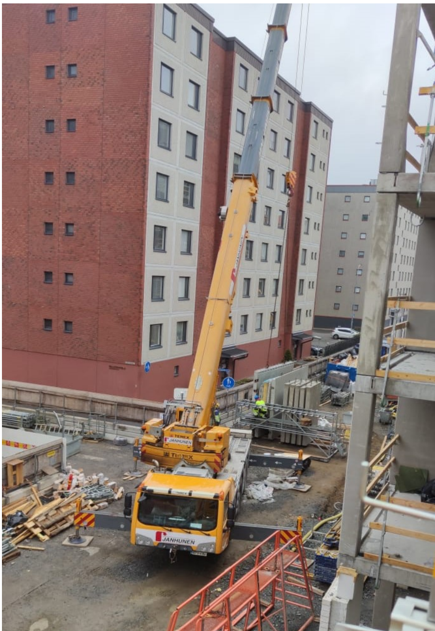
Kuva 13. Autonosturi nostamassa käännettäviä elementtejä elementtifakkiin kohdetyömaalla
