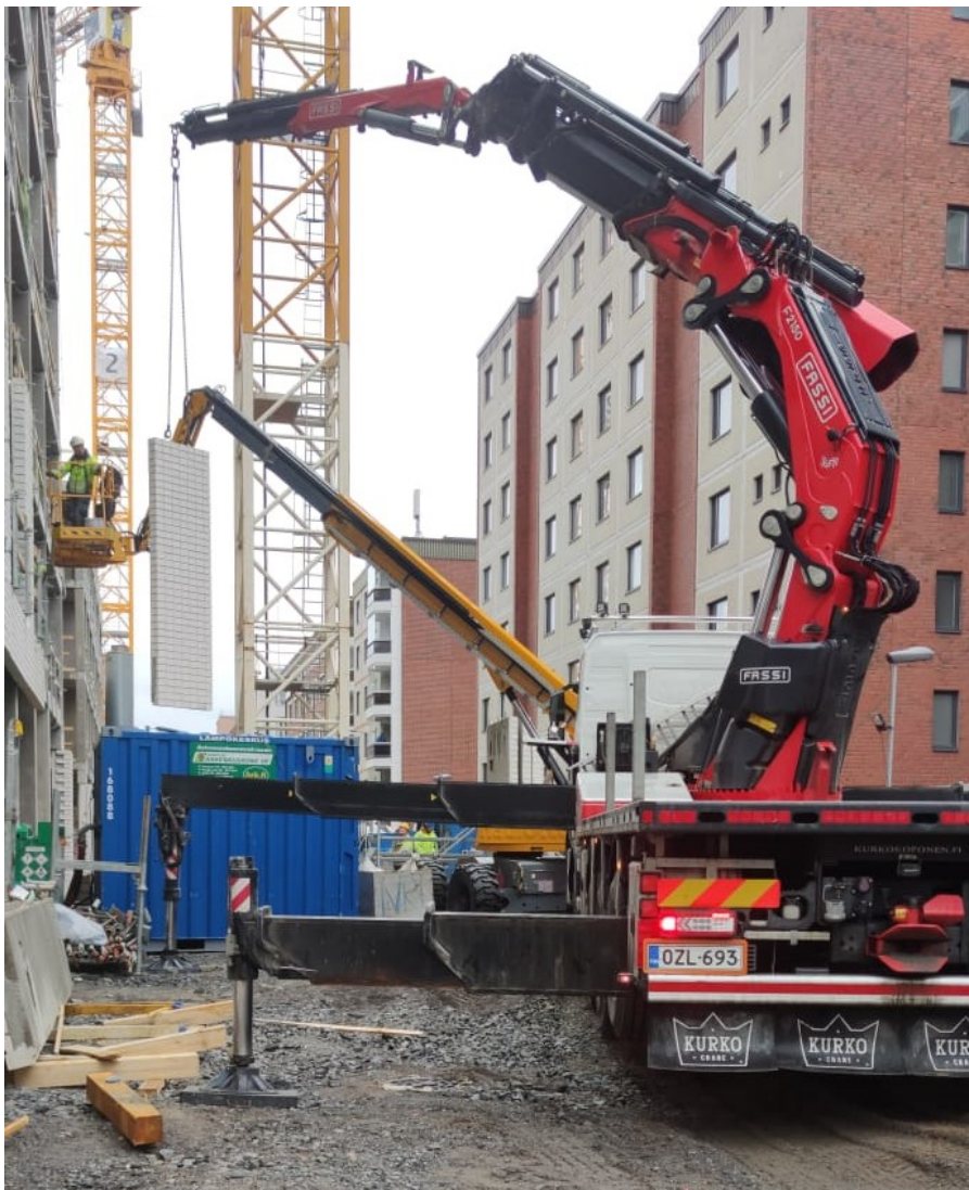
Kuva 15. Nosturiauto asentamassa parvekkeiden kuorielementtejä
