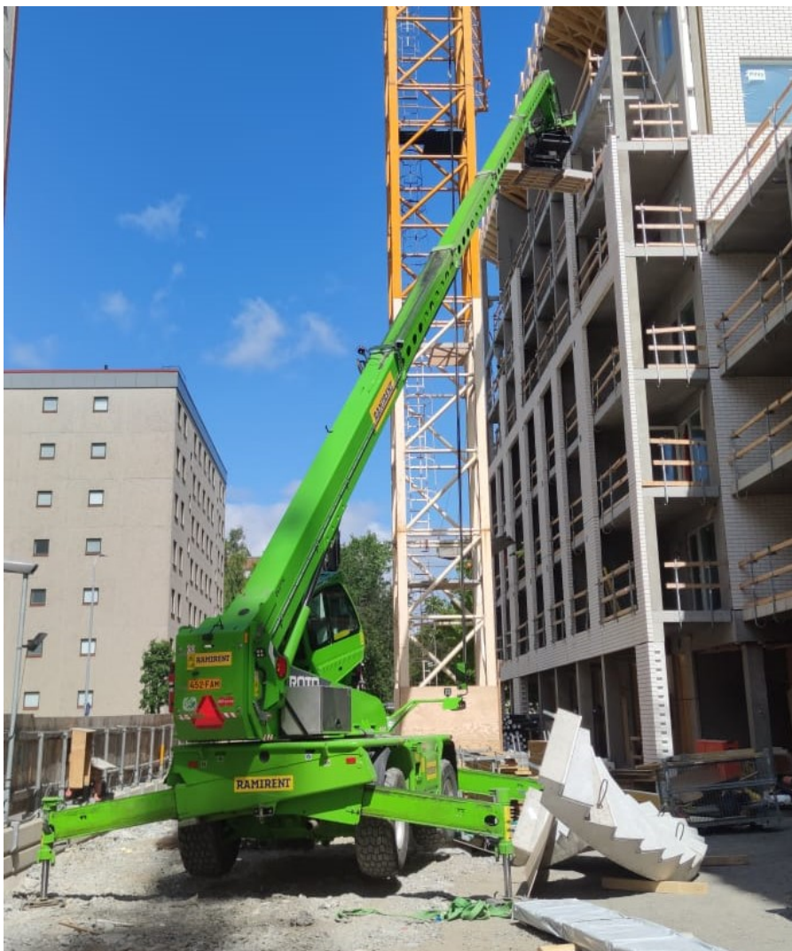
Kuva 16. Kurottaja nostamassa kipsilevyjä parvekkeelle
