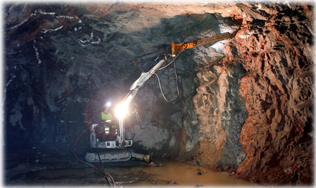
Kuva 8. Porauspuomilla varustettu kaivinkone (Reijo Piispanen)
