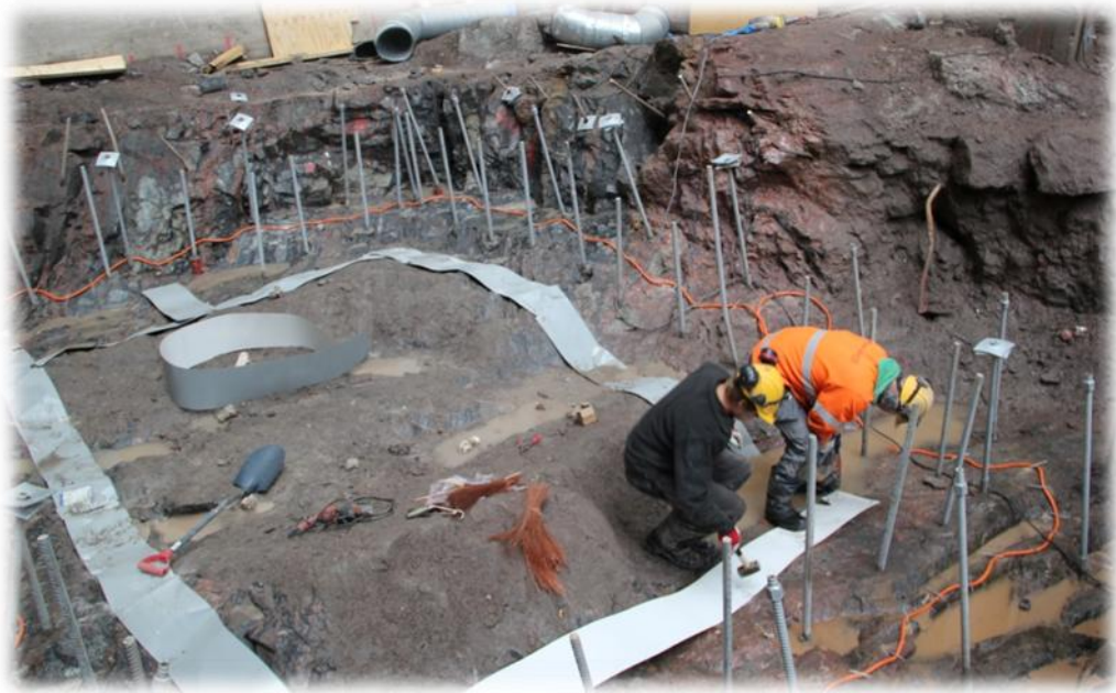
Kuva 7. Kuilun yläpään betonirakenteen tartunnat ja rakolinjan peitelevyt (Timo Kinnunen)
