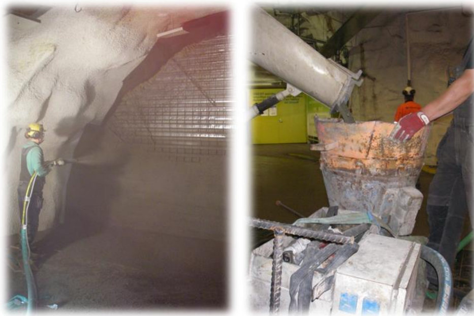
Kuva 15. Suojaseinän kuivaruiskubetonointi (Timo Kinnunen)
