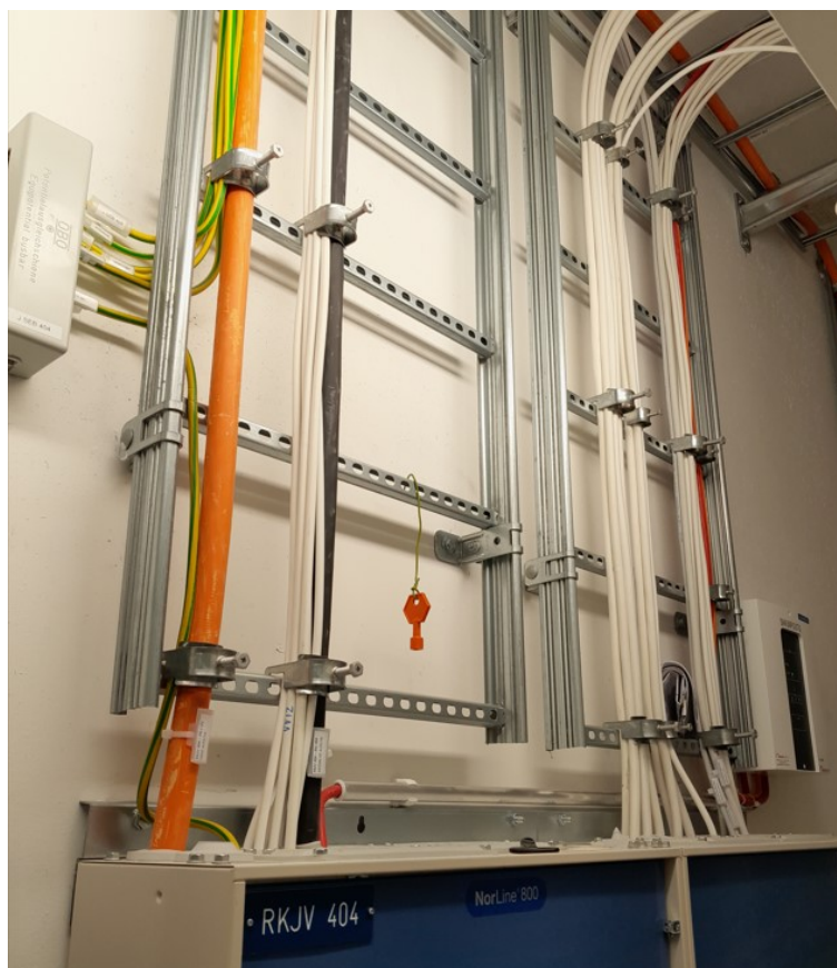
Kuva 11. Ryhmäkeskuksen malliasennus
