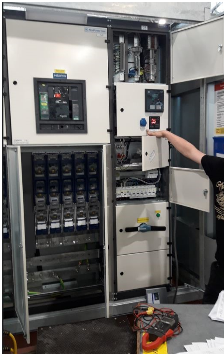
Kuva 13. Puistomuuntamon valmistuksen ja testauksen seuranta kojeistotehtaalla
