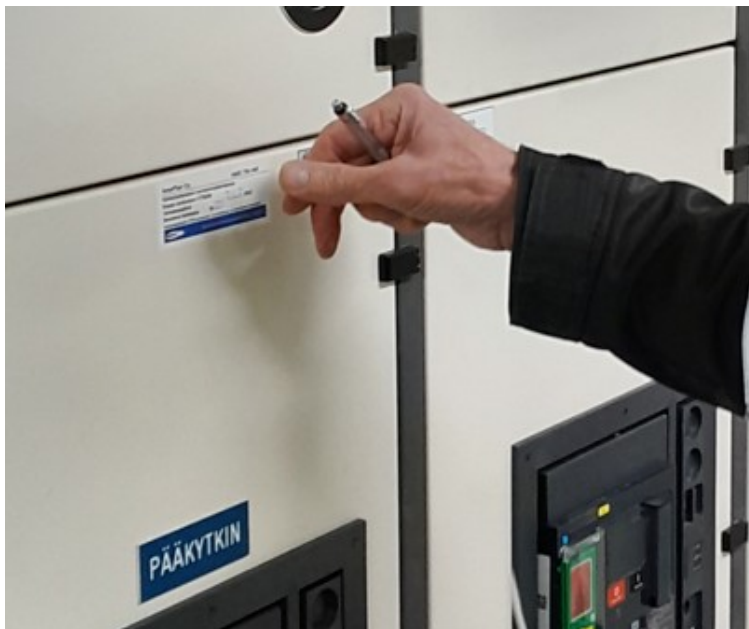
Kuva 15. Pääsähkökeskuksen varmennustarkastus
