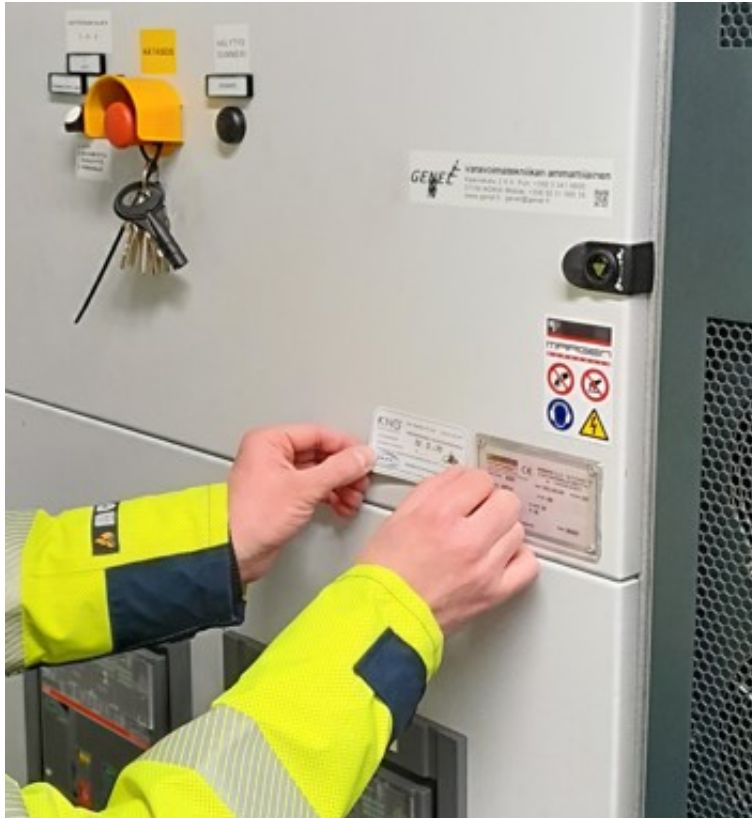
Kuva 16. Varavoimakoneen varmennustarkastus
