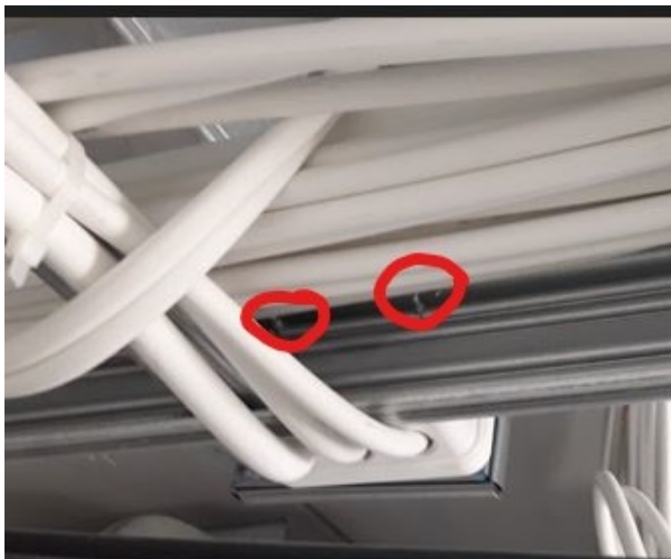
Kuva 9. Rasian kiinnitysruuvit johtotilassa
