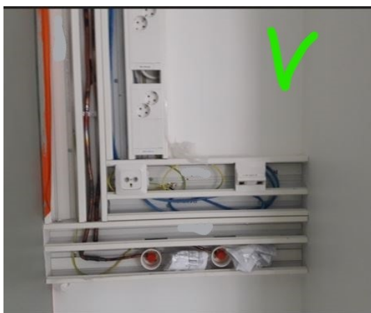
Kuva 10. Sairaalakaasut sähkökanavan alapuolelle
