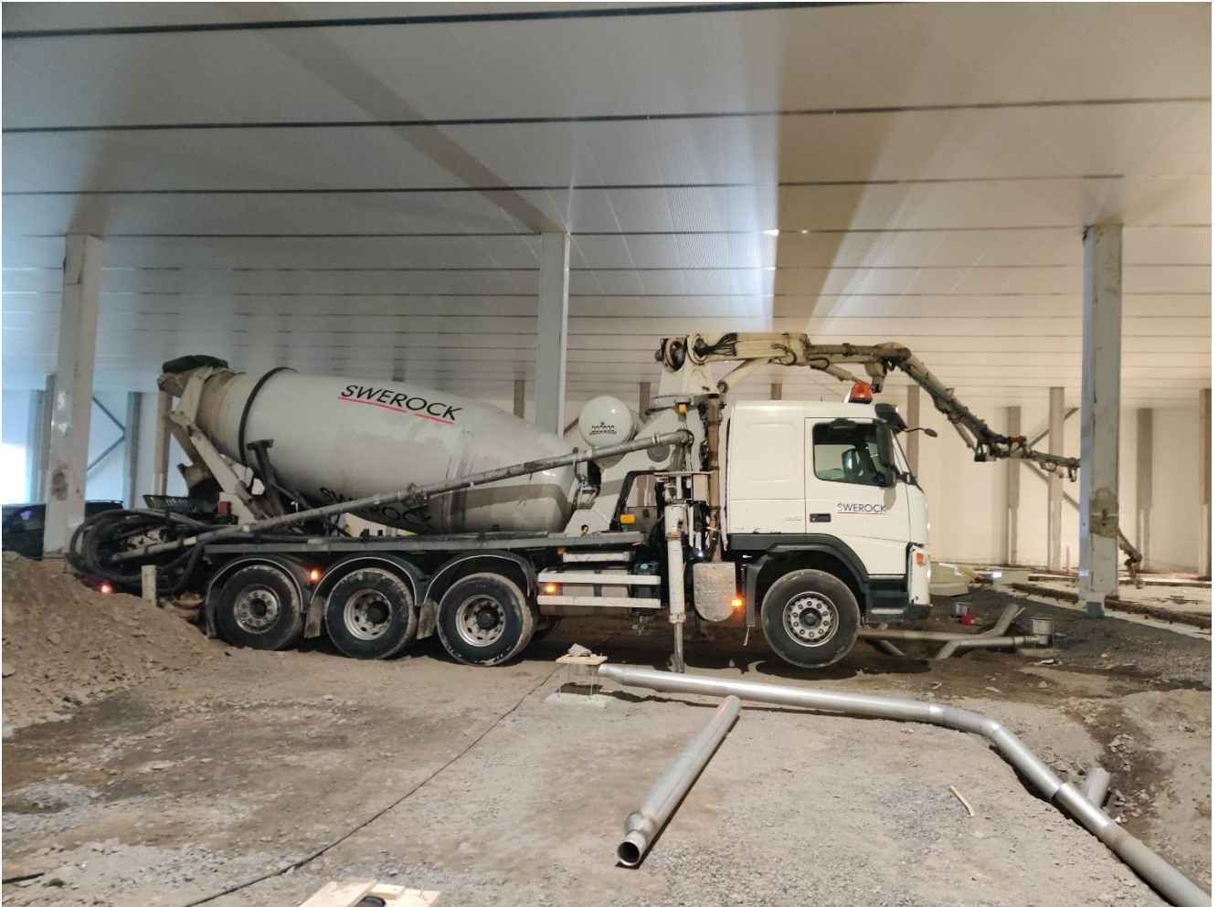
Kuva 11. Kuljetuspumppuauto valmiina lattiavaluun (Laitila, 2022)
