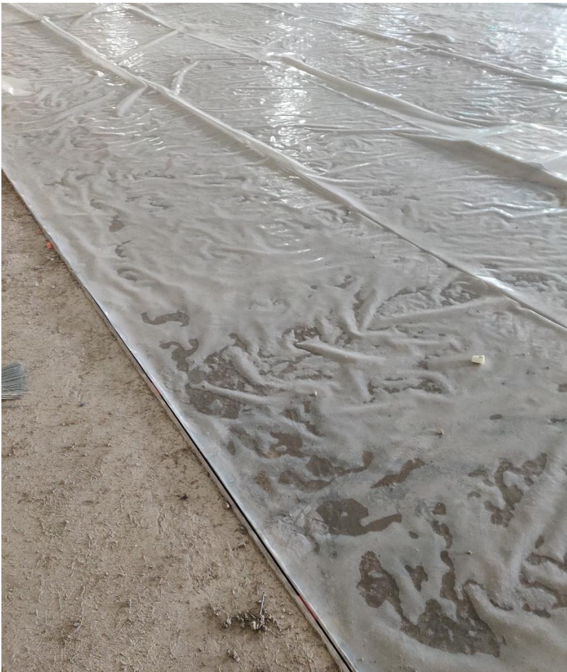
Kuva 14. Betonin jälkihoito suojamuovilla (Laitila, 2022).
