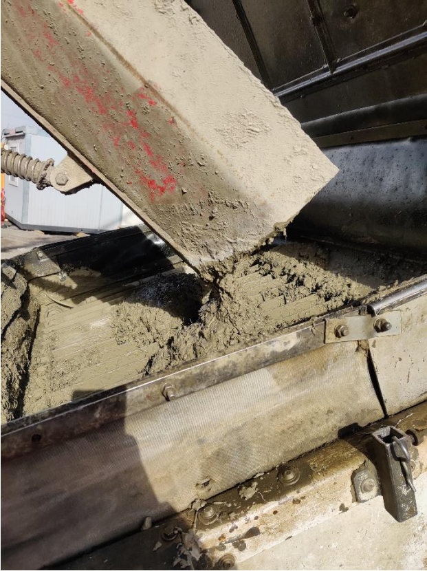
Kuva 5. Valmista kuitubetonia pumppuauton perässä. (Laitila, 2022)
