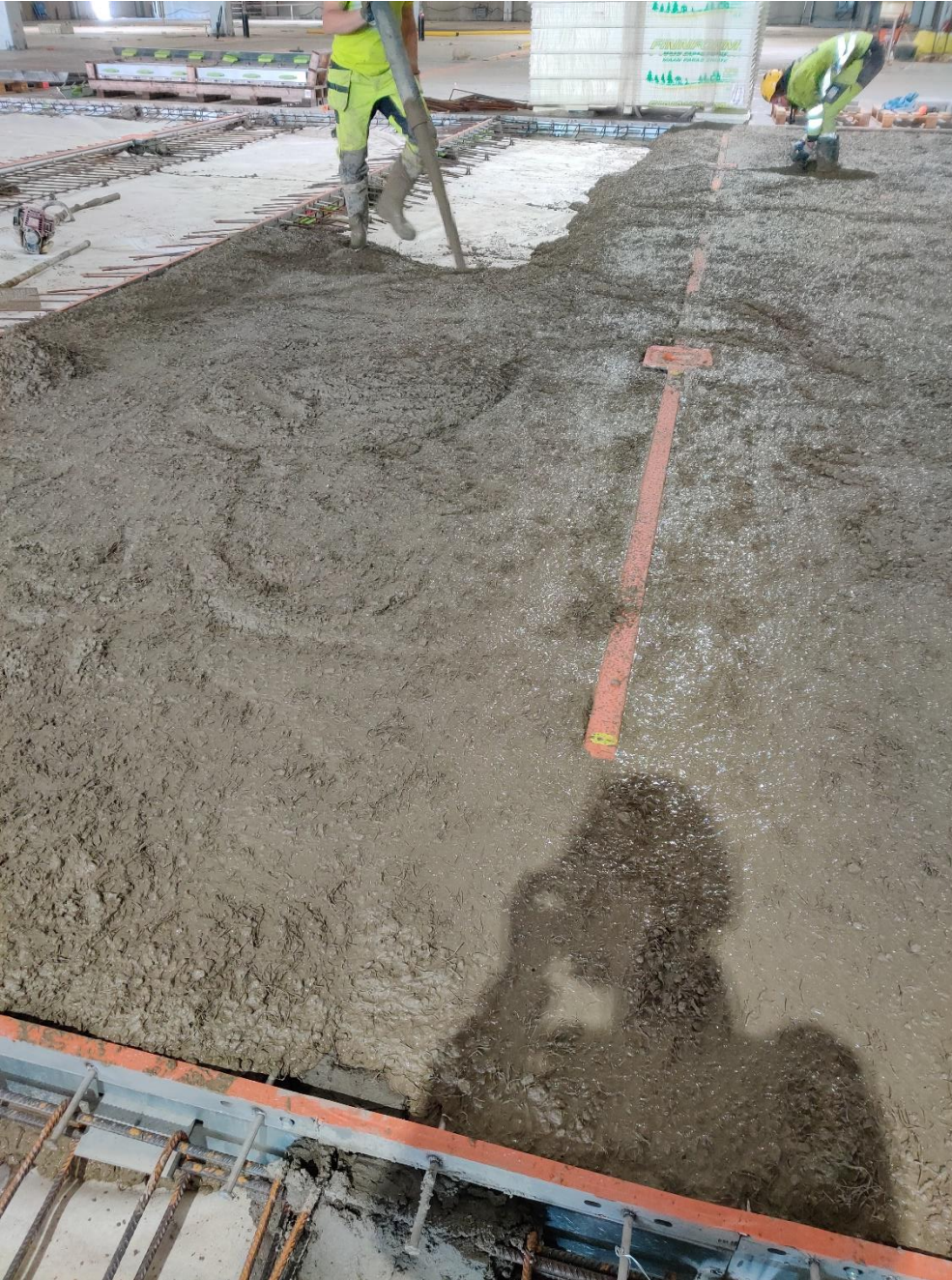
Kuva 13. Betonin pumppaus käynnissä (Laitila, 2022).
