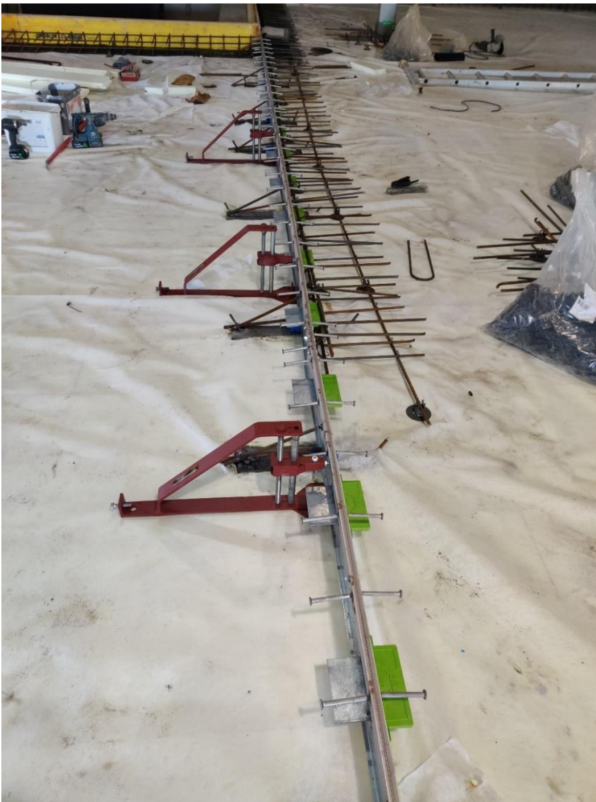
Kuva 7. Liikuntasauaman asennusta asennustyökälulla (Laitila, 2022).
