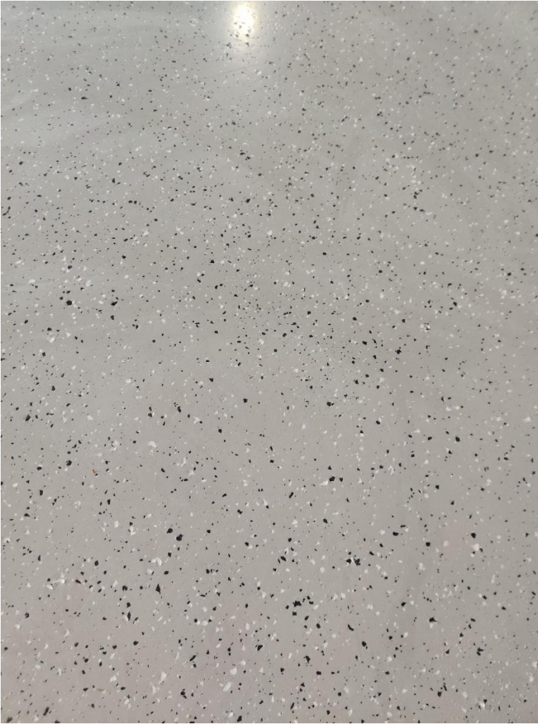
Kuva 15. Valmis polyuretaanipinnoitettu lattia (Laitila, 2022)
