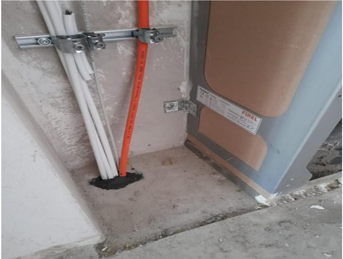
Kuva 12. Esimerkkikohteessa Heka-Gunillantiellä grafiittimassaa on käytetty betonilattian sähköläpiviennissä. [kuvaaja Hieu Tran.]
