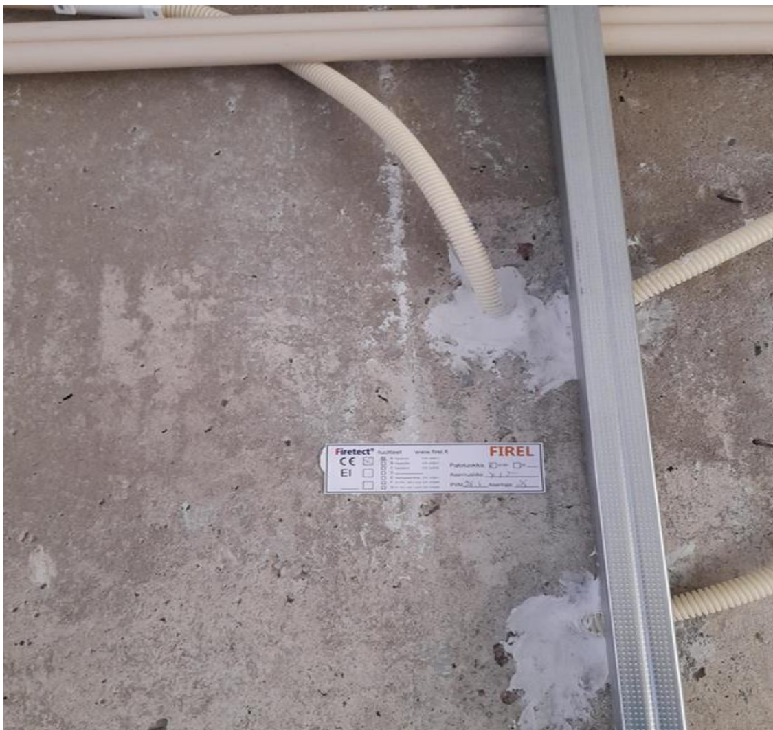
Kuva 8. Esimerkkikohteen Heka-Gunillantien betoniseinärakenteessa oleva sähköläpivienti. [kuvaaja Hieu Tran.]
