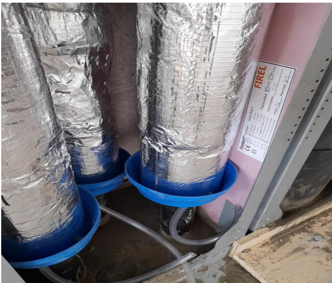
Kuva 11. Esimerkkikohteen Heka-Gunillantien betonivälipohjan lattialäpivienissä käytettiin juotosbetoni palokatkona. [kuvaaja Hieu Tran.]
