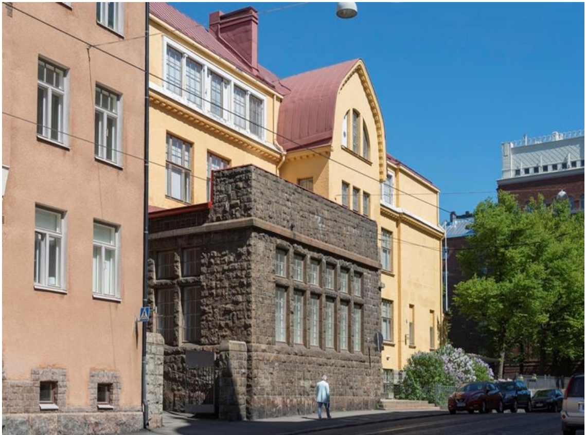
Kuva 2. Tehtaankadun ala-aste eteläpuolinen julkisivu. [21.]
