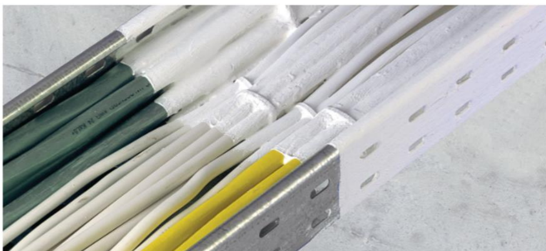
Kuva 14. Palokatkopinnoitemassa (CP 679 A) levitetty sähkökaapeleihin. [19.]
