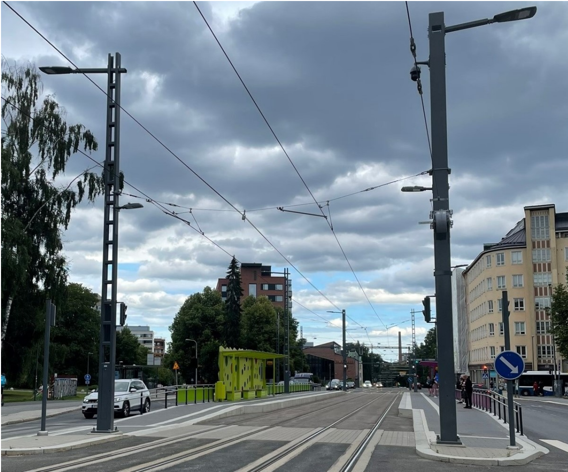
Kuva 5. Raitiotien yhteiskäyttöpylväitä pysäkkialueella.
