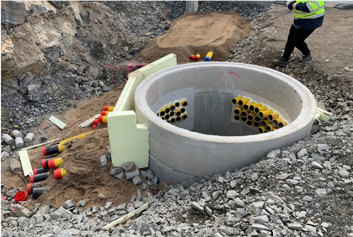
Kuva 8. Kaapelikaivo rakennusvaiheessa.
