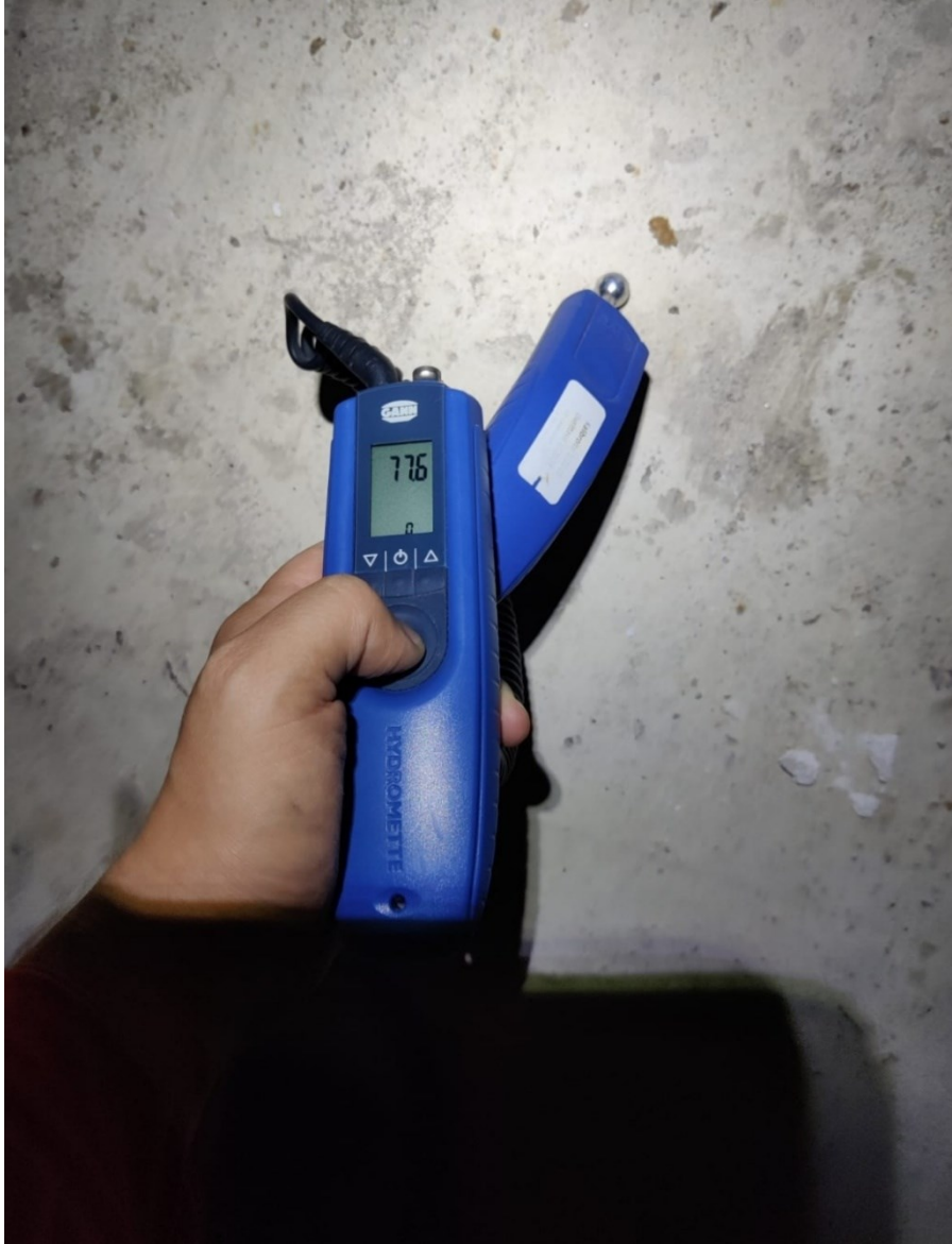
Kuva 9. Kylpyhuoneiden kosteuden mittaus pintakosteusmittarilla.
