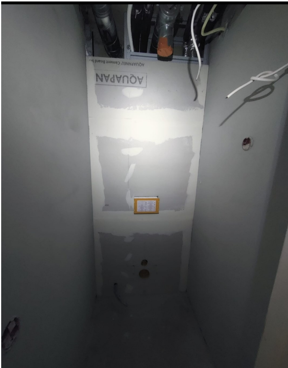
Kuva 8. Seinä WC-elementin levytys.
