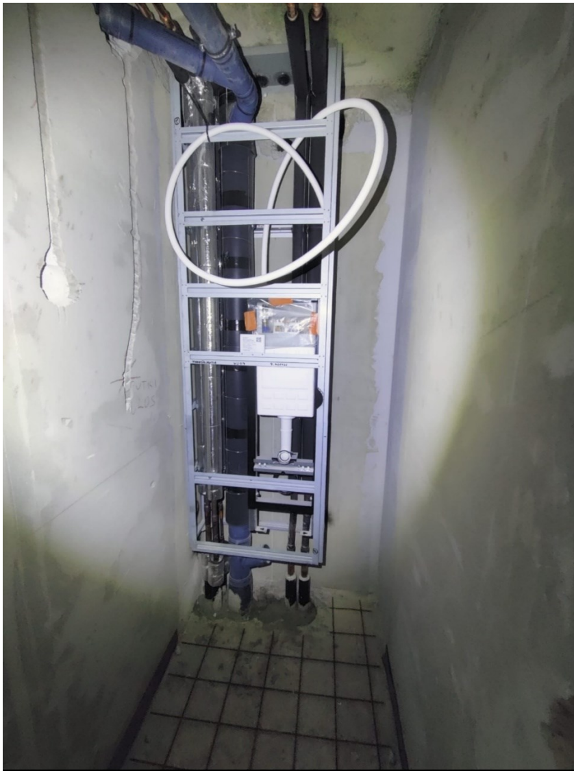
Kuva 7. Seinä WC-elementti asennettuna.
