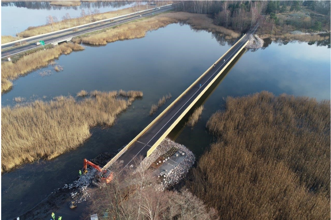
Kuva 5. Läntinen Tarvonsilta ilmasta kuvattuna.
