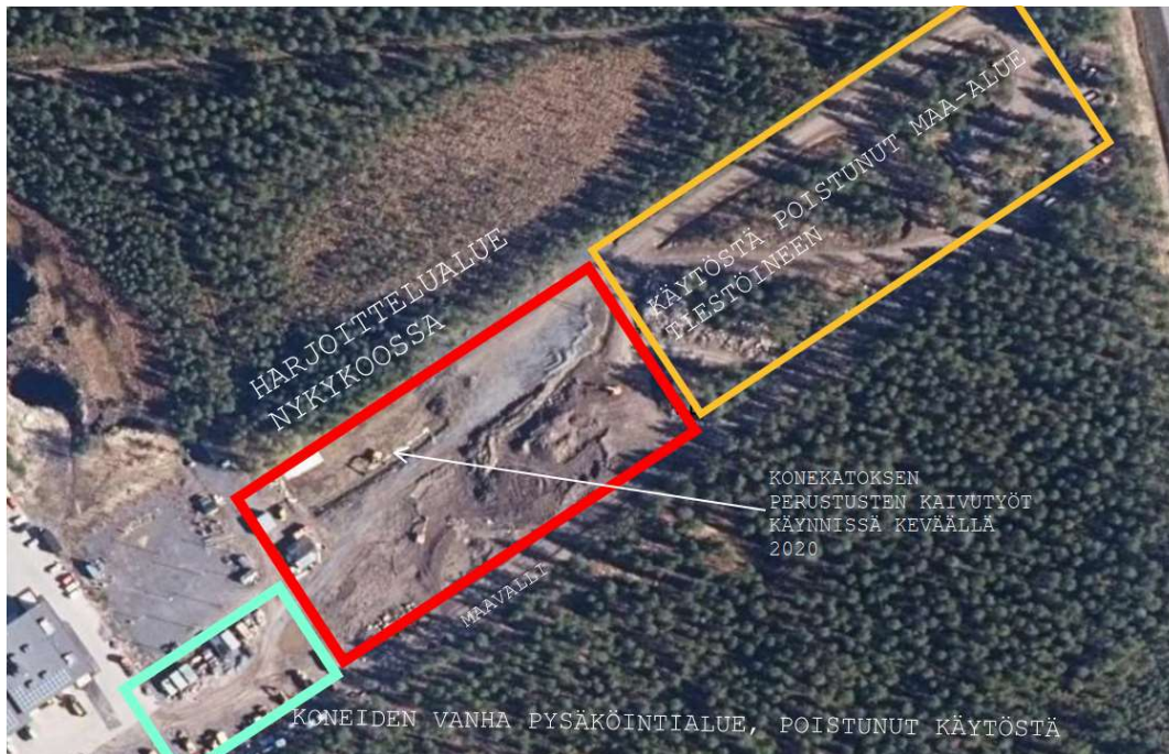
KUVA 1. Alueen ilmakuva keväältä 2020. (Maanmittauslaitos 2020)
