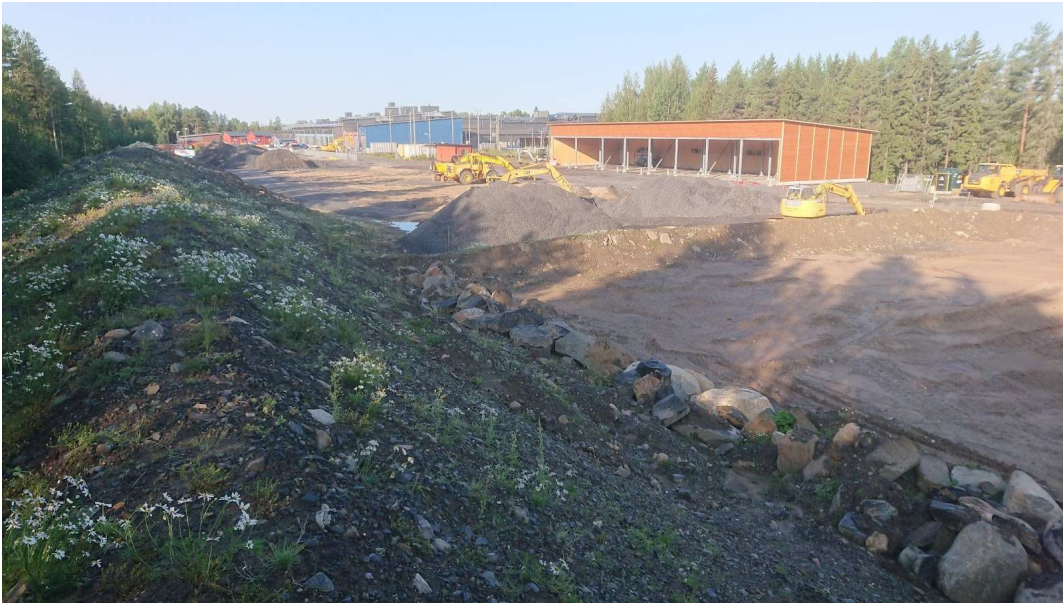
KUVA 3. Yleisnäkymää harjoittelualueelle. Vasemmalla alueen kaakkoisrajalla sijaitseva maavalli. Oikealla puolella 3D-kenttä, konekalustoa parkissa, polttoaineasema sekä rakenteilla oleva konekatos. Edessä keskellä ja taaempänä vasemmalla näkyy erilaisia murskelaatuja kasoissa. (Palovaara 2021)
