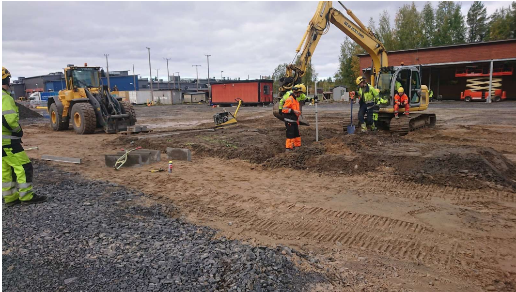
KUVA 6. Harjoittelualueella betonisen reunakiven asennusharjoituksia. (Palovaara 2021)
