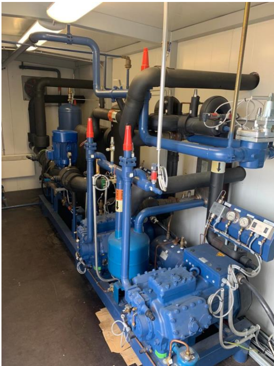
KUVA 10. Ranuan jäähallin kylmäkoneisto
