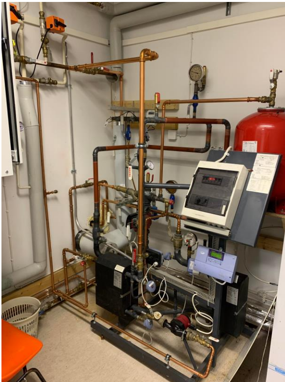
KUVA 5. Jäähallin lämmönjakokeskus
