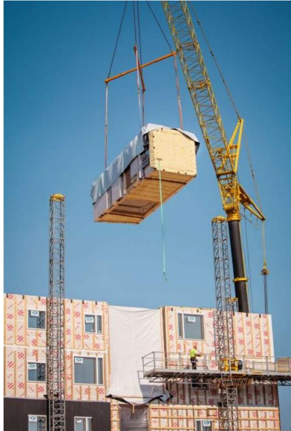
Kuva 6. Tilaelementeistä koottu talo koostuu esimerkiksi asuinhuoneiston kokoisista lohkoista (Karjalainen 2017).
