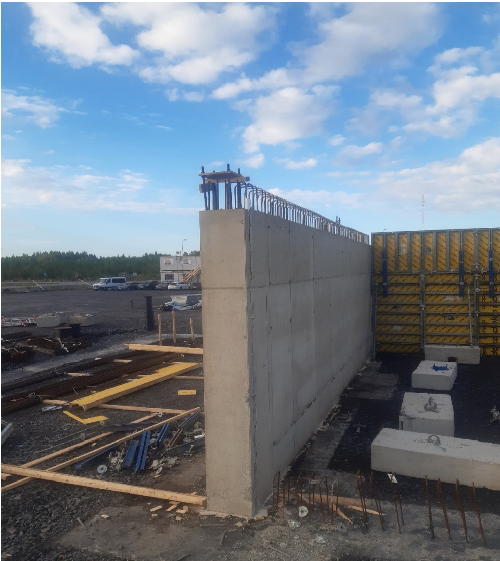
Kuva 1. Paikallavaluseinä valmiina (Salimäki, 2022).
