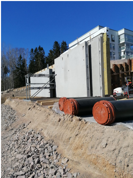
Kuva 1. Seinäelementtien varastointi työmaalla.
