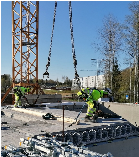
Kuva 2. Onteloelementtien asennus.
