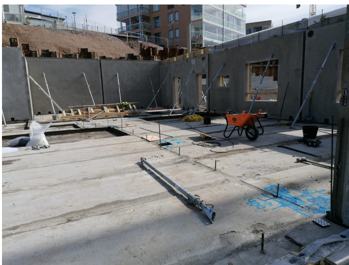
Kuva 3. Seinäelementtien asennus.
