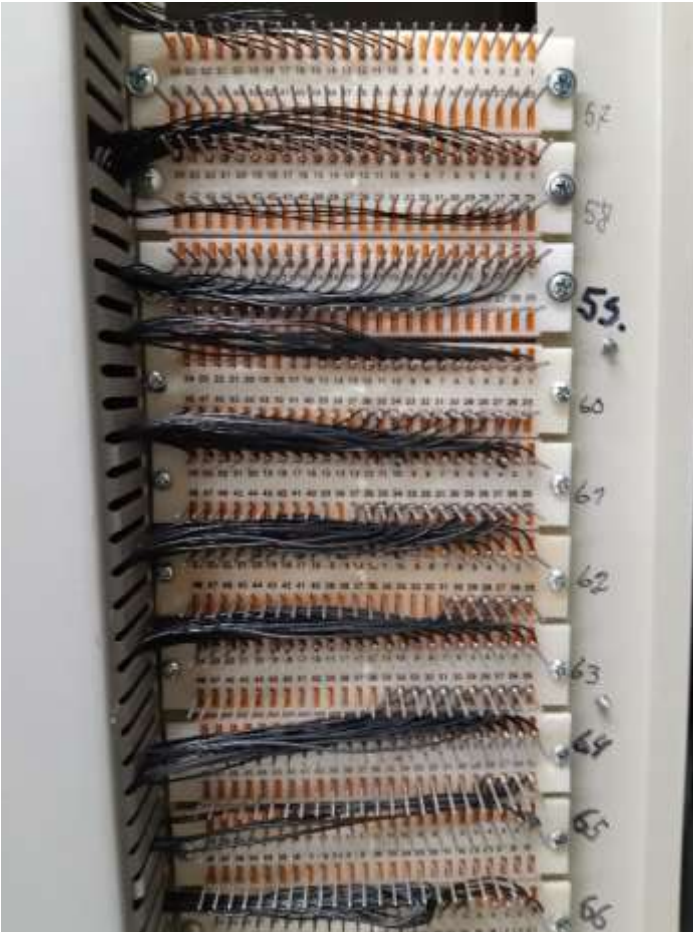
Kuvio 15. XC-liittimiltä AXJ-levylle lähtevä johdotus
