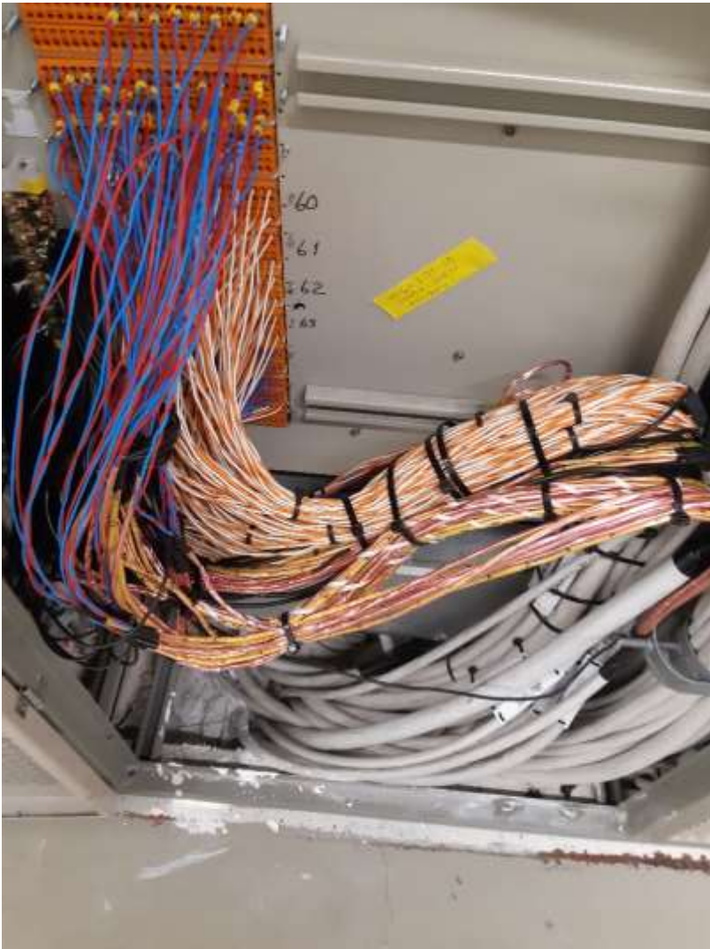
Kuvio 14. XC-liittimille kytketyt runkokaapelit
