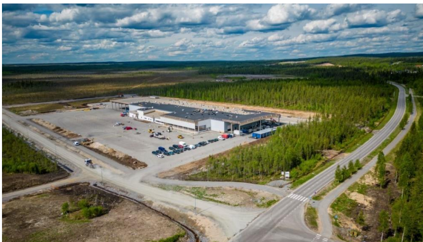
Kuva 1. Uusi tehdashalli rakenteilla (Norrhydro 2022c)
