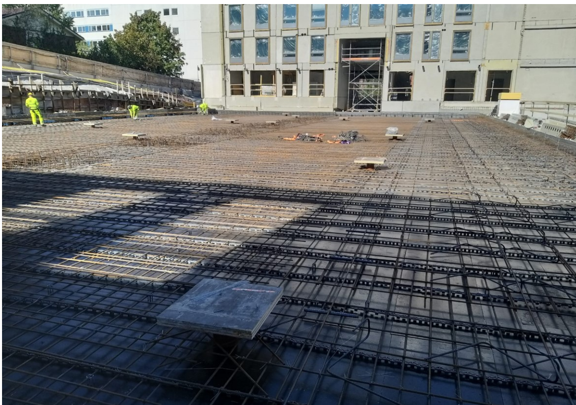
Kuva 3. Raudoituksen alapinta ja kaivojen varaukset muoviputkella ja vanerilla.
