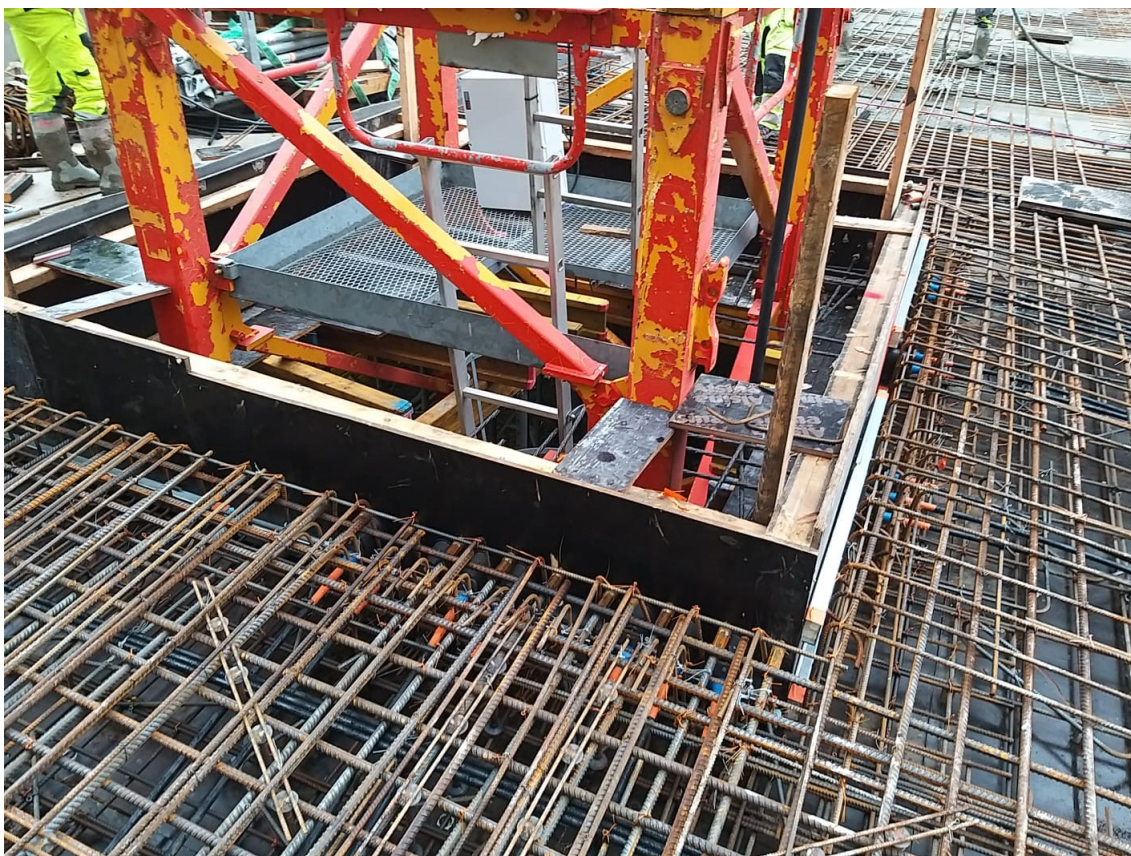
Kuva 8. Nosturiaukon varaus. Aukko valetaan umpeen nosturin purun jälkeen.
