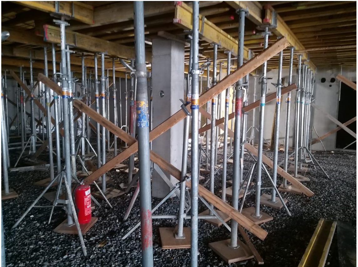
Kuva 12. Muottien tuenta kannen alapuolella.
