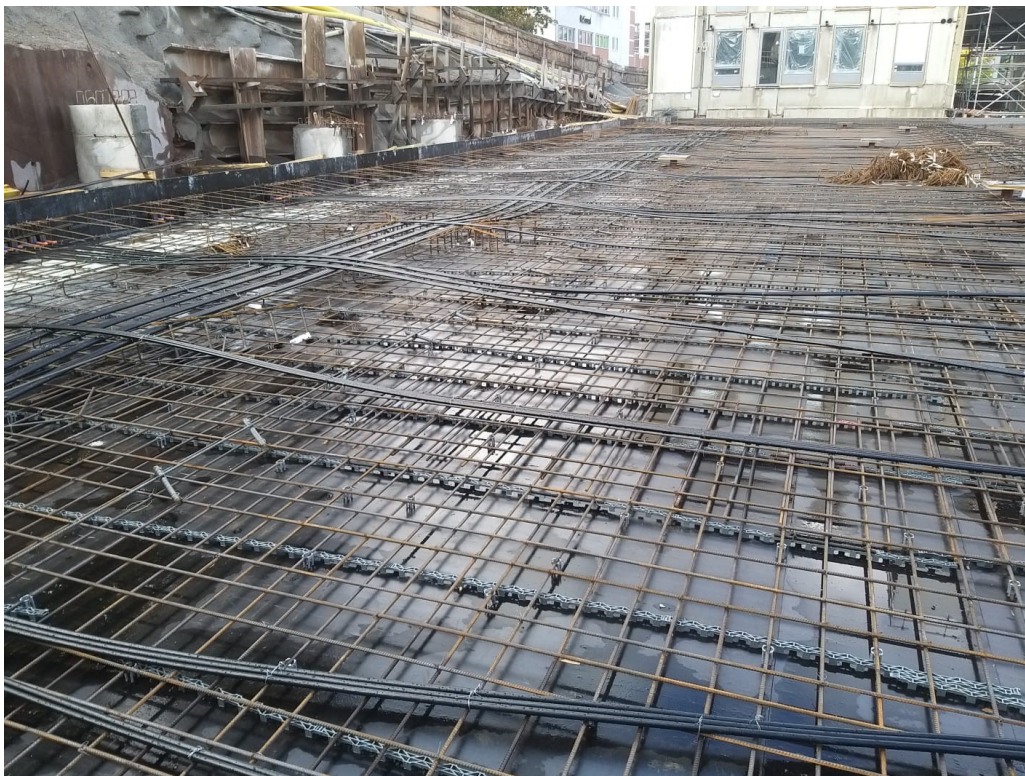
Kuva 6. Vanamon punostyöt valmiit. Reunamuotilla välttyttiin jännityslaatikoilta.
