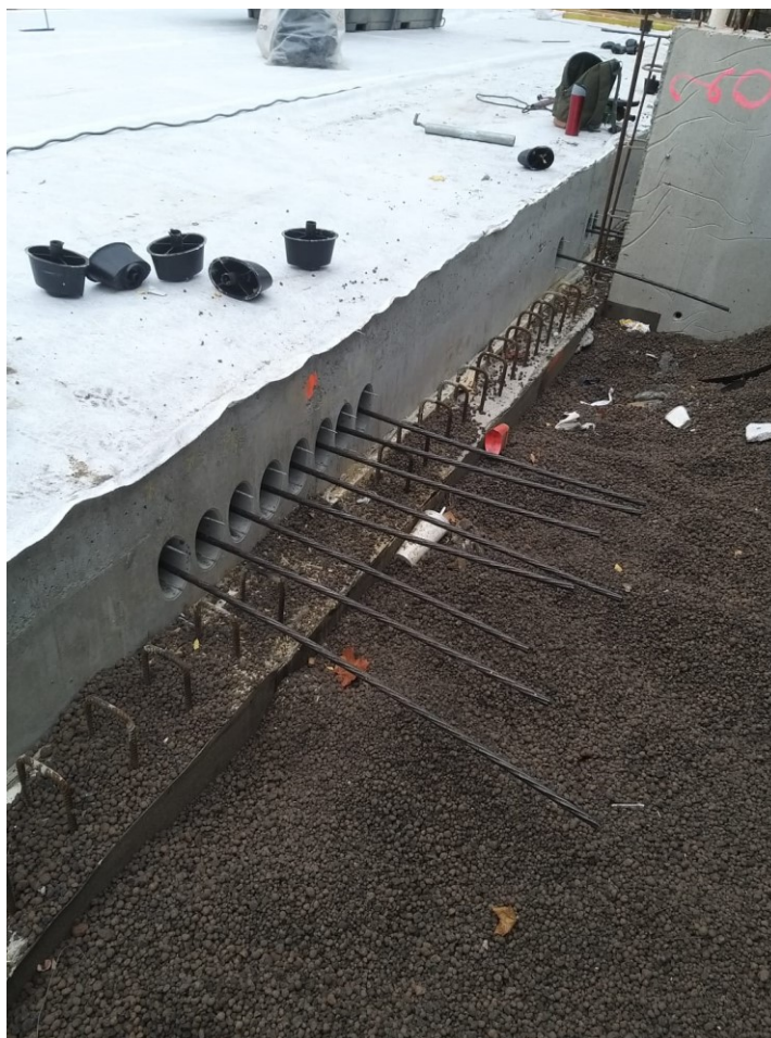
Kuva 7. Seinäelementit asennettiin valun jälkeen, jotta jännityslaatikoilta vältyttiin.
