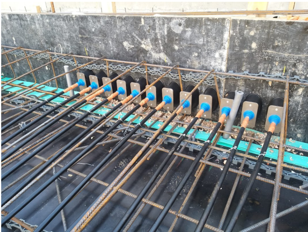
Kuva 5. Punosankkurit kiinnitettynä reunamuottiin.
