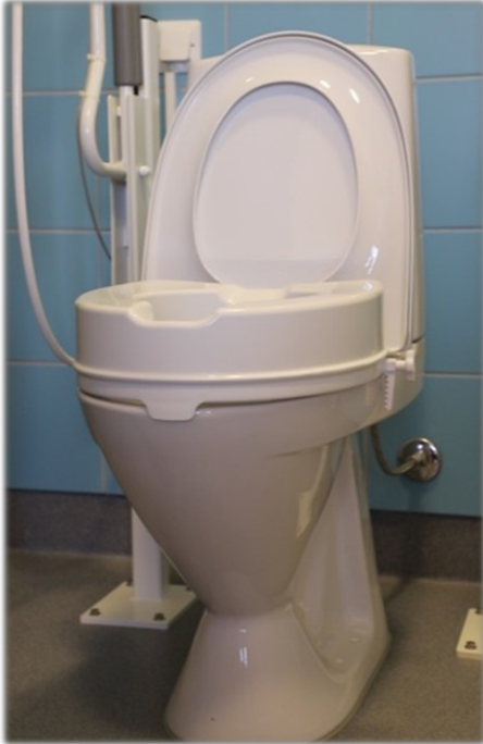
Kuva 5. Wc-istuimen koroke. Juho Näyhä
