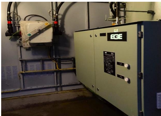
Kuva 9 Tuulivoimakompensointilaitteistoa (Hakkarainen, 2018)
