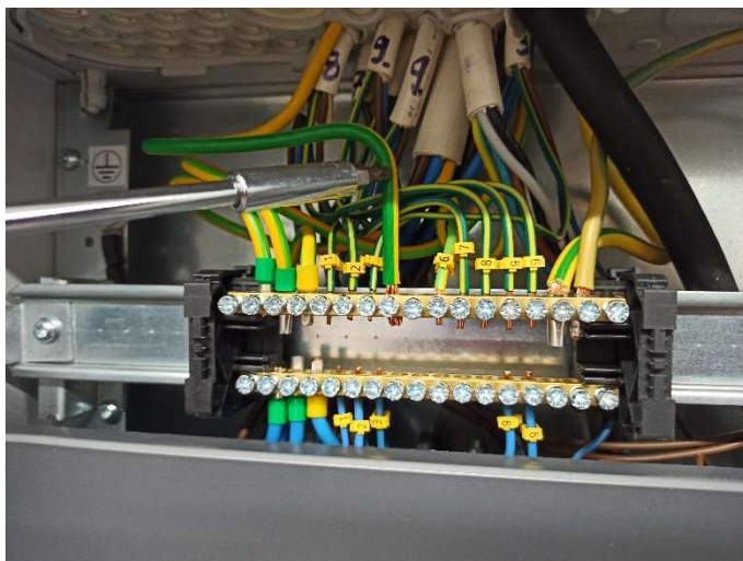
KUVA 12. Maadoitusten lisääminen sähkökeskukseen
