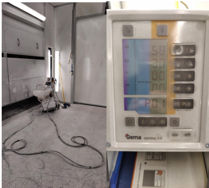
Kuva 33. maalausammio. (Nieminen. 2022) Kuva 34. Maalauslaitteen käyttöpaneeli. (Nieminen. 2022)
